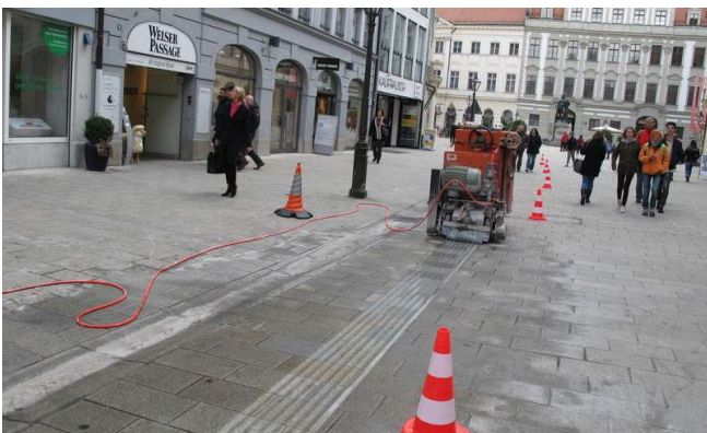
Blindenleitsysteme werden in den Boden eingefräst (Quelle: B4B Wirtschaftsleben Schwaben)
