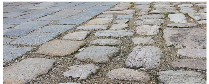
Vorher: große Pflastersteine mit großen Fugen (Quelle: Bayern barrierefrei)
