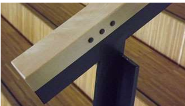
Handlauf mit taktil erkennbaren Elementen (Quelle: Bayern barrierefrei)
