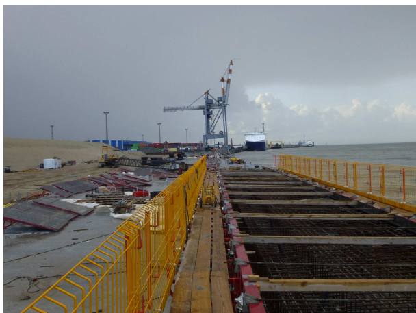
Stahlbetonüberbau mit Holm
