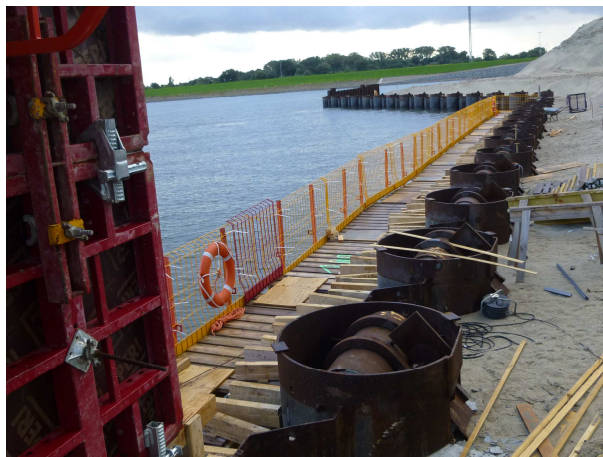
Anschluß Schrägpfahl/Stahlrohr
