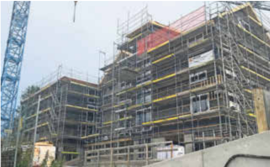
Der Neubau des Wohnheims Flora in Einsiedeln nach Abschluss des Rohbaus Ende Juni. Bild: PD
