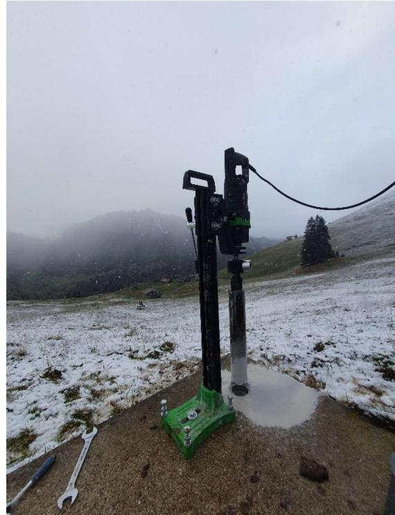
Kernbohrung für Einführung Lichtmasten in die Beschneigungsschächte
