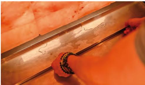
WICHTIG: Die Wasserauffangschale unter den Salzsteinen darf auf keinen Fall überlaufen und muss regelmäßig gereinigt werden. Verkrustungen können durch Einweichen der Schale entfernt werden.
