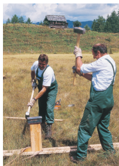
Mitarbeiter des Forstbetriebs Tamsweg beim Dammbau
