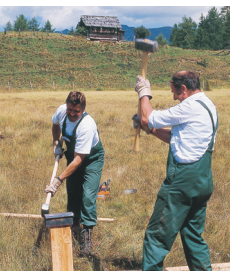
Errichtung der ersten Holzdämme am Überling
