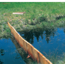
Erfolgreicher Einstau im Entwässerungsgraben
