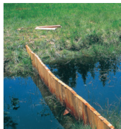
Einstau im Entwässerungsgraben
