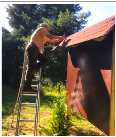
Andreas deckt das Hotel mit Bitumenschindeln ein.
