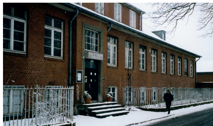
Das einstige Verwaltungsgebäude des Kettenwerks stand zwischen den beiden Einmündungen des Essener Bogens in die Essener Straße. Bis zum Abriss 1999 hatte der „Kunstverein Kettenwerk“ dort seinen Sitz. Foto: René Senenko
