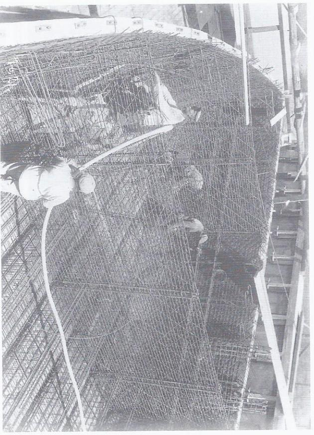
*„Auf die Innenwand des Docks, die genau der Außenhaut des Schiffes entspricht, wird nach Verlegen der Eisenbewehrung der Beton durch Pressluft mittels des Torcretors aufgespritzt. Bodenwangen und Deck werden in einfacher Schalung hergestellt und alle Ausrüstungsteile sofort mit einbetoniert.“ Foto: Technische Informationsbibliothek und Universitätsbibliothek Hannover; Signatur Haus 2: f 3452*
