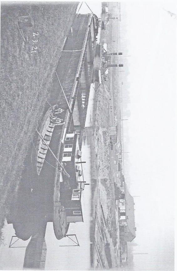
„Nach etwa sechs Tagen wird durch Öffnen der im Boden des Docks befindlichen Schieber Wasser eingelassen; während das Dock an Auftrieb verliert und sich langsam auf die Sohle des Hafens absenkt, löst sich das Schiff unter der Wirkung des Auftriebes aus der Innenhaut des Docks ab und schwimmt auf, so dass es nach Entfernen der einen Dockquerwand herausgefahren werden kann.“ Foto: Technische Informationsbibliothek und Universitätsbibliothek Hannover, Signatur Haus 2: f 3452
