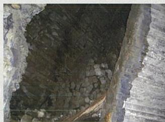
図-10 ニッ小屋隧道覆工の崩壊
