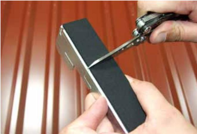
Dichtpad am Stoß aufschneiden.
