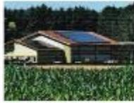
**Zwei neue Gemeinde-Photovoltaikanlagen** liefern einen wichtigen Teil des Strombedarfs. 70 kWp am Dach des ANZ versorgen die **Kläranlage**. Von April bis August konnte der Stromerkauf um 45% gesenkt werden. 6,45 kWp versorgen die **Kinderkrippe Hainsdorf**. Ein Lithium-Ionen-**Stromspeicher mit 9,8 kWh** erhöht den Eigenverbrauch. Finanziert wurden die Anlagen durch Bundesförderungen (KIP), KEM-Invest-Förderung des Klimafonds sowie Eigenmittel.
