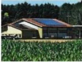
**Zwei neue Gemeinde-Photovoltaikanlagen** liefern einen wichtigen Teil des Strombedarfs. 70 kWp am Dach des AWZ versorgen die **Kläranlage**. Von April bis August konnte der Stromeinkauf um 45% gesenkt werden. 6,45 kWp versorgen die **Kinderkrippe Hainsdorf**. Ein Lithium-Ionen-**Stromspeicher mit 9,8 kWh** erhöht den Eigenverbrauch. Finanziert wurden die Anlagen durch Bundesförderungen (KIP), KEM-Invest-Förderung des Klimafonds sowie Eigenmittel.
