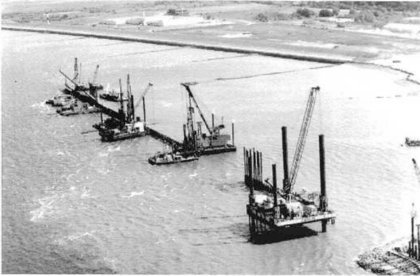
Hafenbaustelle Mehrzweckumschlaganlage im August 1995
