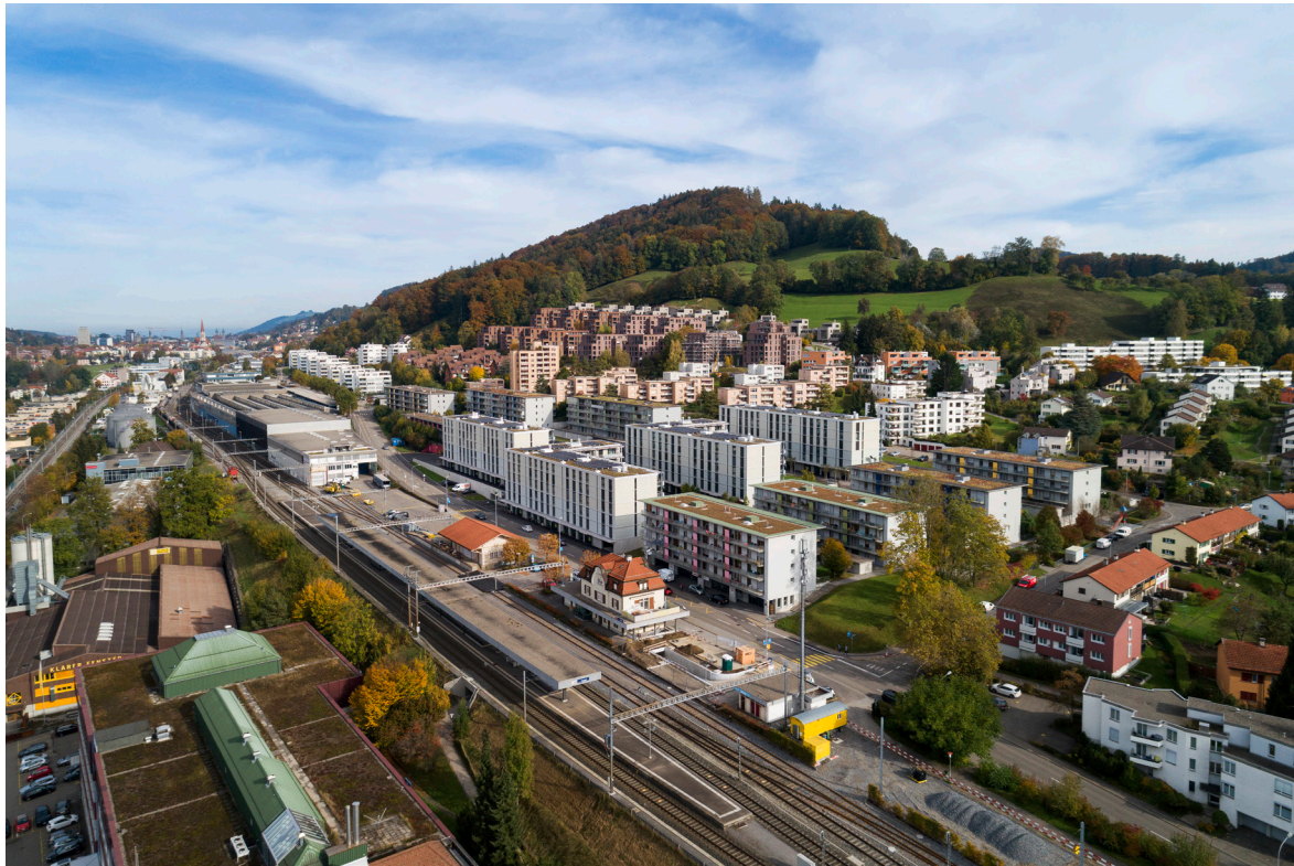
Das gewürfelte Quartier beim Bahnhof Haggen im Süden St. Gallens.
