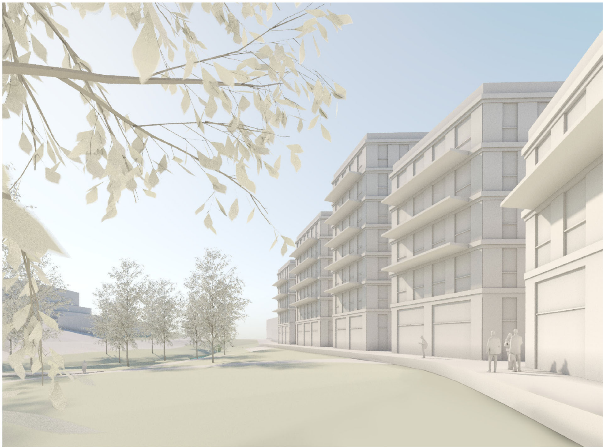
Blick entlang des neuen Erschliessungswegs
