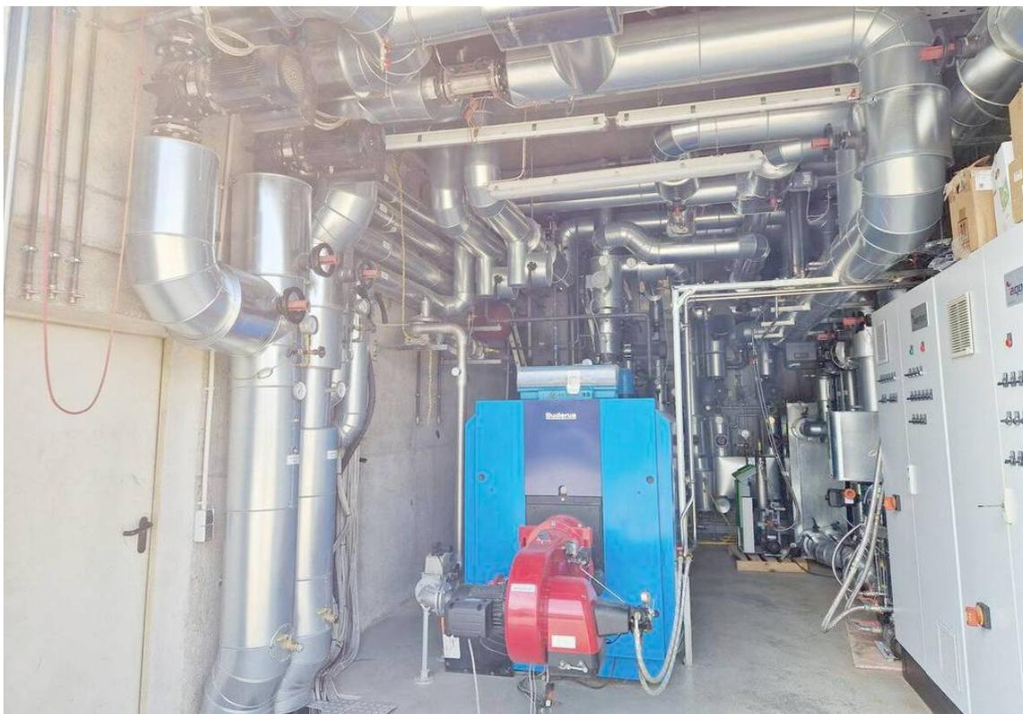
Ein Blick in die Heizzentrale der Biogasanlage Sproll in Mittelbiberach. Von hier werden 600 Haushalte mit Wärme versorgt. (Fotos: Maïke Daub)
