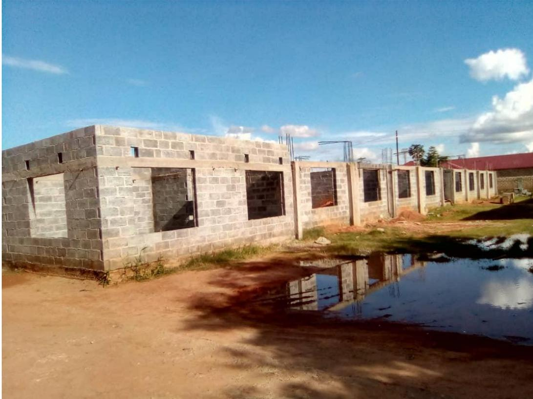
Die Säulen der Außenwände des Gebäudes wurden stabilisiert.
