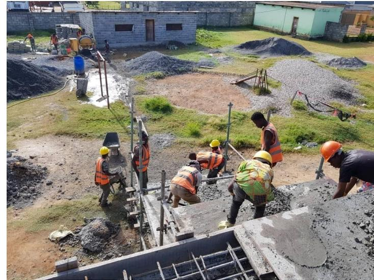
Bau der Betondecke, so dass zu einem späteren Zeitpunkt noch der 1. Stock gebaut werden kann.
