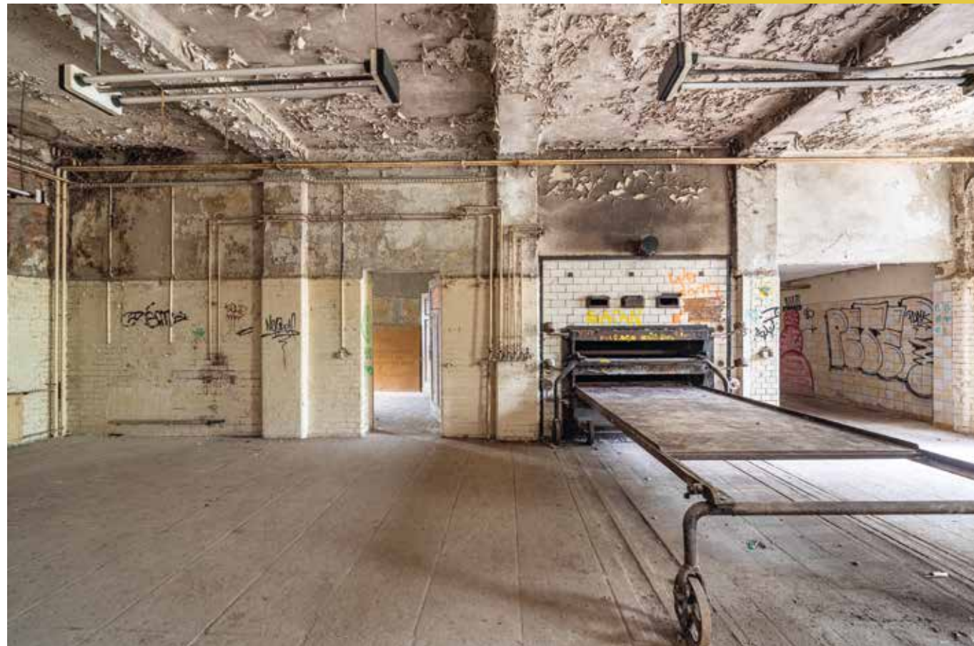
Bild: Backstube der Heilstätter Bäckerei vor der Sanierung
