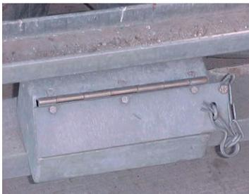
Abbildung 15: Metallkiste mit Sicherungssplint
