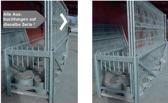
Abbildung 13: Ausrichten der Zaunelemente im Transportrahmen
