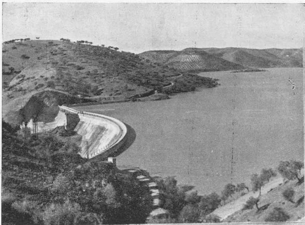
Fig. 12. — Presa y vaso del embalse de La Breña.
