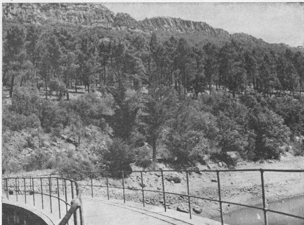
Fig. 3. — Silúrico de la Garganta desde la presa de embalse.
