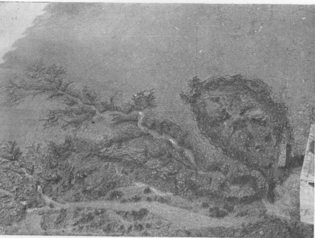
Fig. 10. — Fondo del embalse del Guadalmellato junto al paramento de aguas arriba de la presa. Limos erosionados por la corriente.
