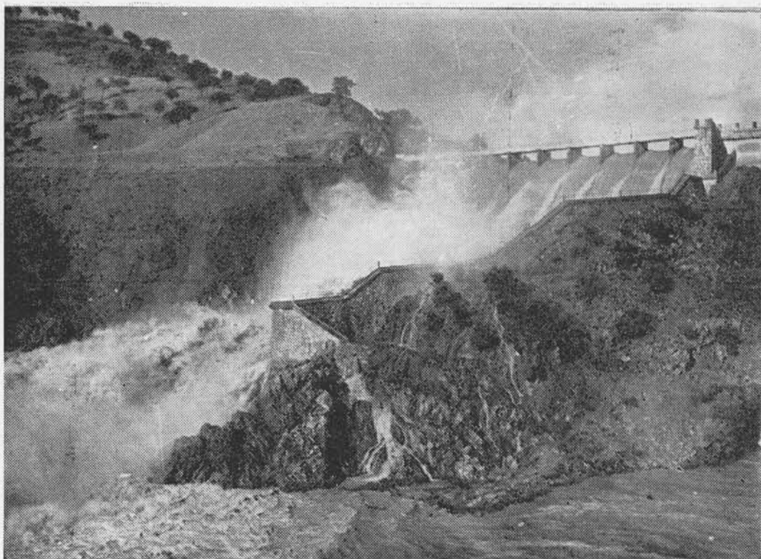
Fig. 11. — Presa de La Breña vertiendo por el aliviadero. Enero 1959.
