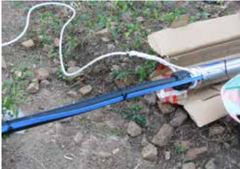
Die Wasserpumpe, Fabrikat Pedrollo, wird mit dem Elektrokabel und dem Druckrohr verbunden und am Tragseil in den Pumpenschacht abgesenkt.
