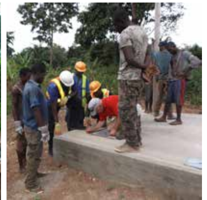
Das Fundament wird vorbereitet und betoniert. Die Standorte für die vier Stützenfüsse werden eingemessen.
