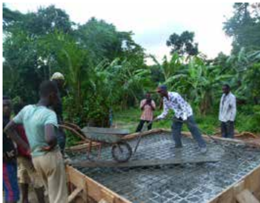
Das Fundament wird vorbereitet und betoniert. Die Standorte für die vier Stützenfüsse werden eingemessen.
