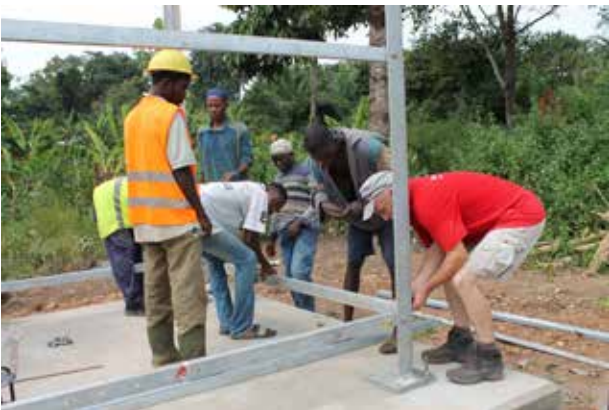
Befestigung mit Klebeanker Hilti
