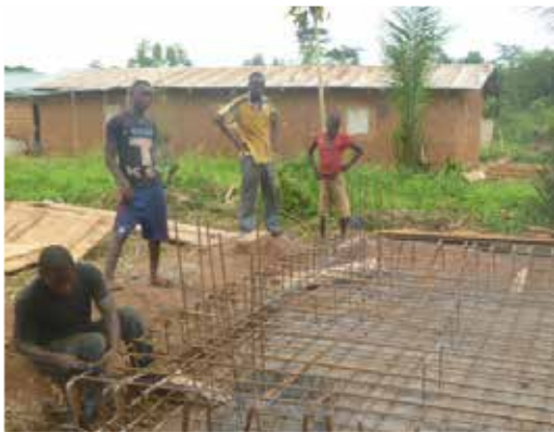
Das Fundament wird vorbereitet und betoniert. Die Standorte für die vier Stützenfüsse werden eingemessen.
