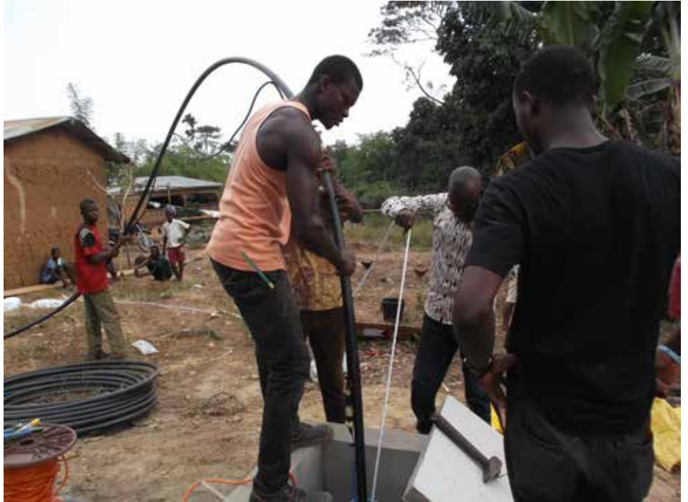
Die Wasserpumpe, Fabrikat Pedrollo, wird mit dem Elektrokabel und dem Druckrohr verbunden und am Tragseil in den Pumpenschacht abgesenkt.
