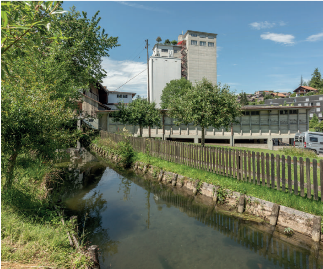
Kanal und Silo
