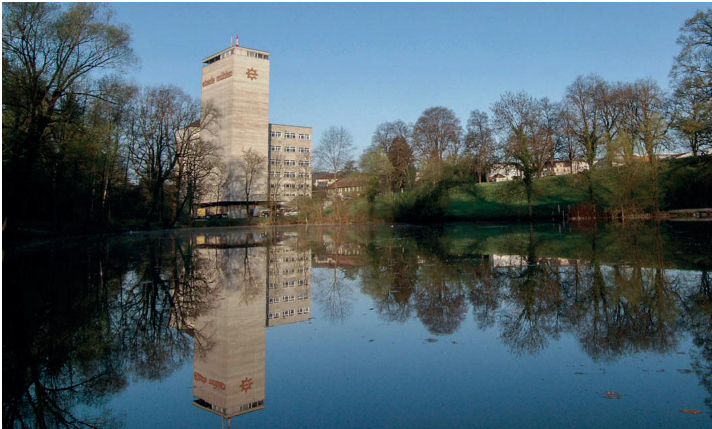
Umnutzung Mühle Rickenbach ehemals Eberle Mühlen in Gossau Furrer Jud Architekten
