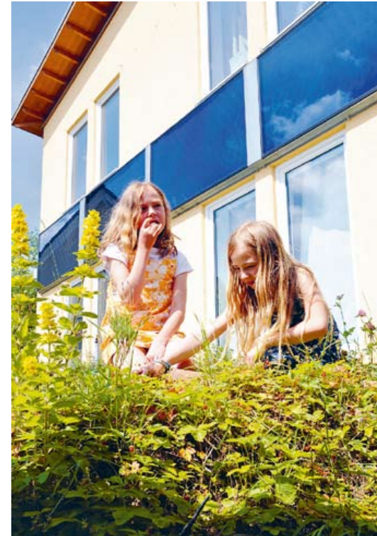
▲ Eine vertikale Montage der Kollektoren ist problemlos machbar – ein optischer Vorteil bei der Gestaltung von Fassaden.
