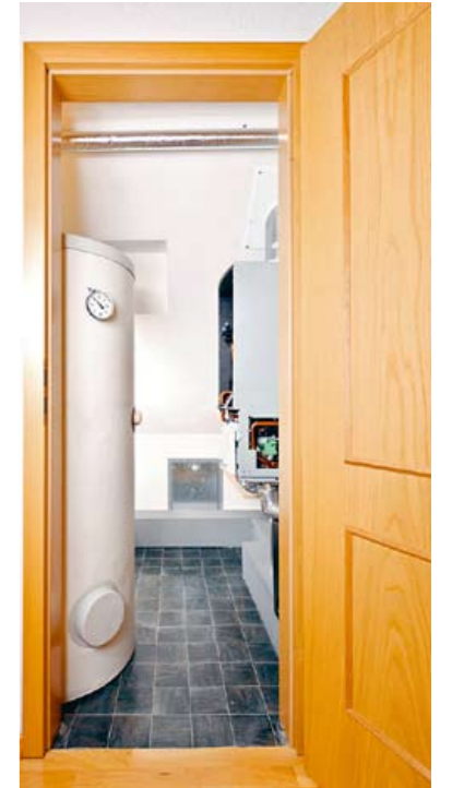
▲ Auch eine Umrüstung auf solare Heizungsunterstützung vorhandener Speicher ist manchmal möglich. Ein alter 400-Liter-Warmwasserspeicher dient nun als Pufferspeicher.
