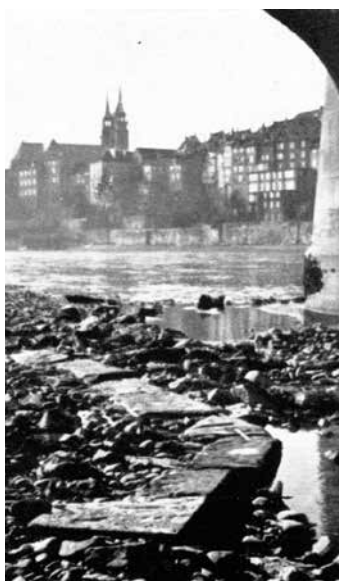
Fundament erster mittelalterlicher Brückenpfeiler von der Kleinbasler Seite her 1932. (Bild: Gustav Schäfer)
