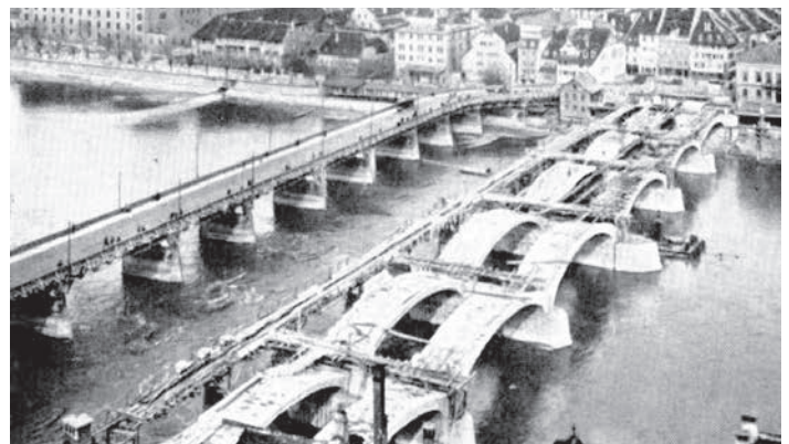
Die Mittlere Brücke im Bau und links daneben die provisorische, um 1904. (Bild: Baudepartement Basel-Stadt)
