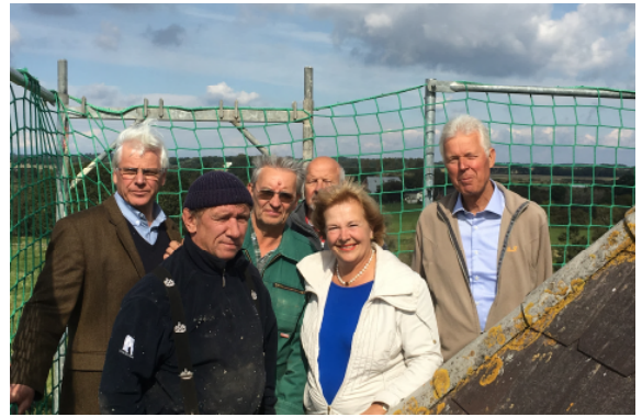
19.09.17: Baubegehung der St.-Jürgen-Kirche in Grube mit dem Architekten Torsten Ewers und den Handwerkern zum Startschuss der Bauarbeiten.
