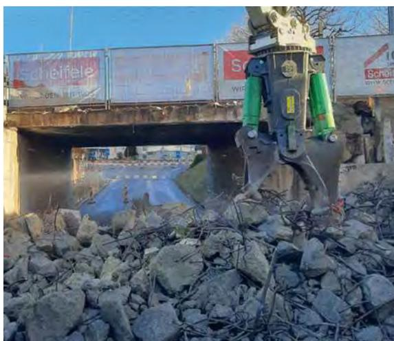
Grosses Bruchmaterial, optimal für den Recycling-Kreislauf
