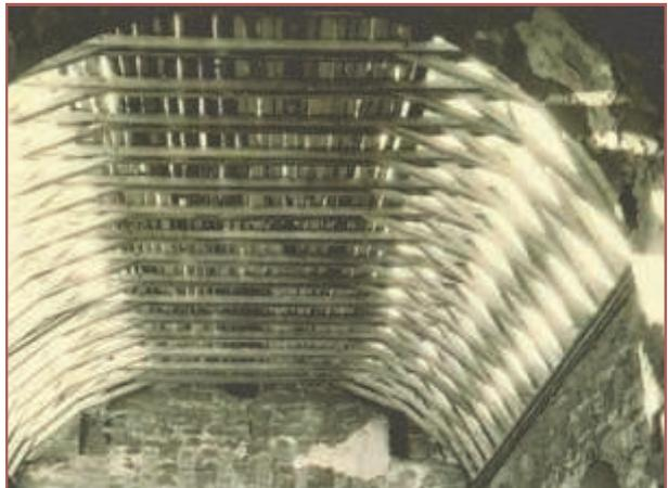
Dachkonstruktion des Mittelschiffes
