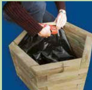
Zum Ausschlagen Ihres Pflanzkübels und Hochbeetes empfehlen wir Ihnen einen Folienzuschnitt an der Innenseite des Gefäßes an zu tackern. Um ein Wasserreservoir zu schaffen, das häufiges Gießen erspart, füllen Sie vor der Bepflanzung eine etwa 10 cm hohe Kiesschicht ein. Staunässe kann dadurch verhindert werden, indem man die Folie oberhalb der Kiesschicht mit Löchern versieht.
