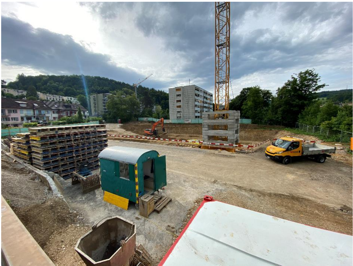
31. Mai 2025: Der Kran steht, der Aushub nimmt Form an.
