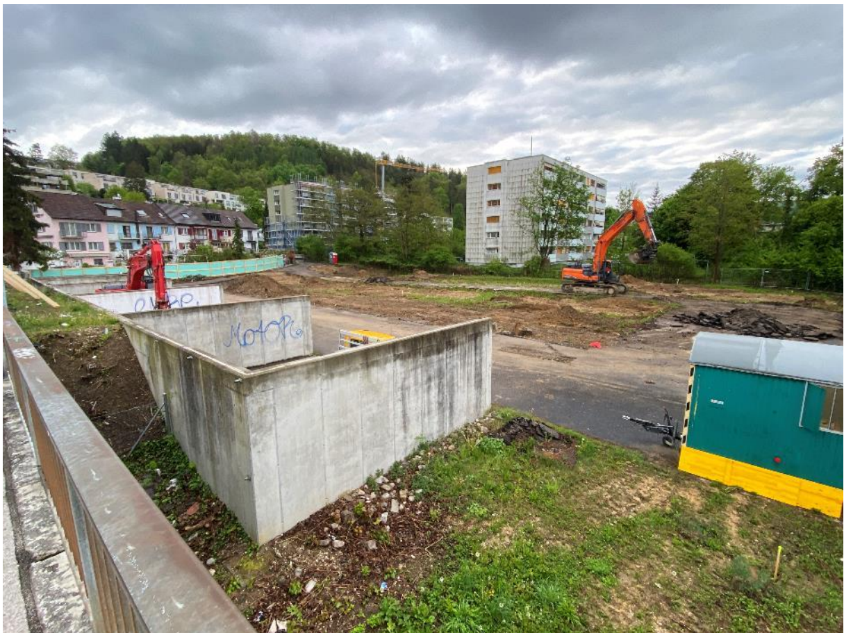
23. April 2025: das Gelände ist eingezäunt, 2 Bagger fahren auf und entfernen den Asphalt
