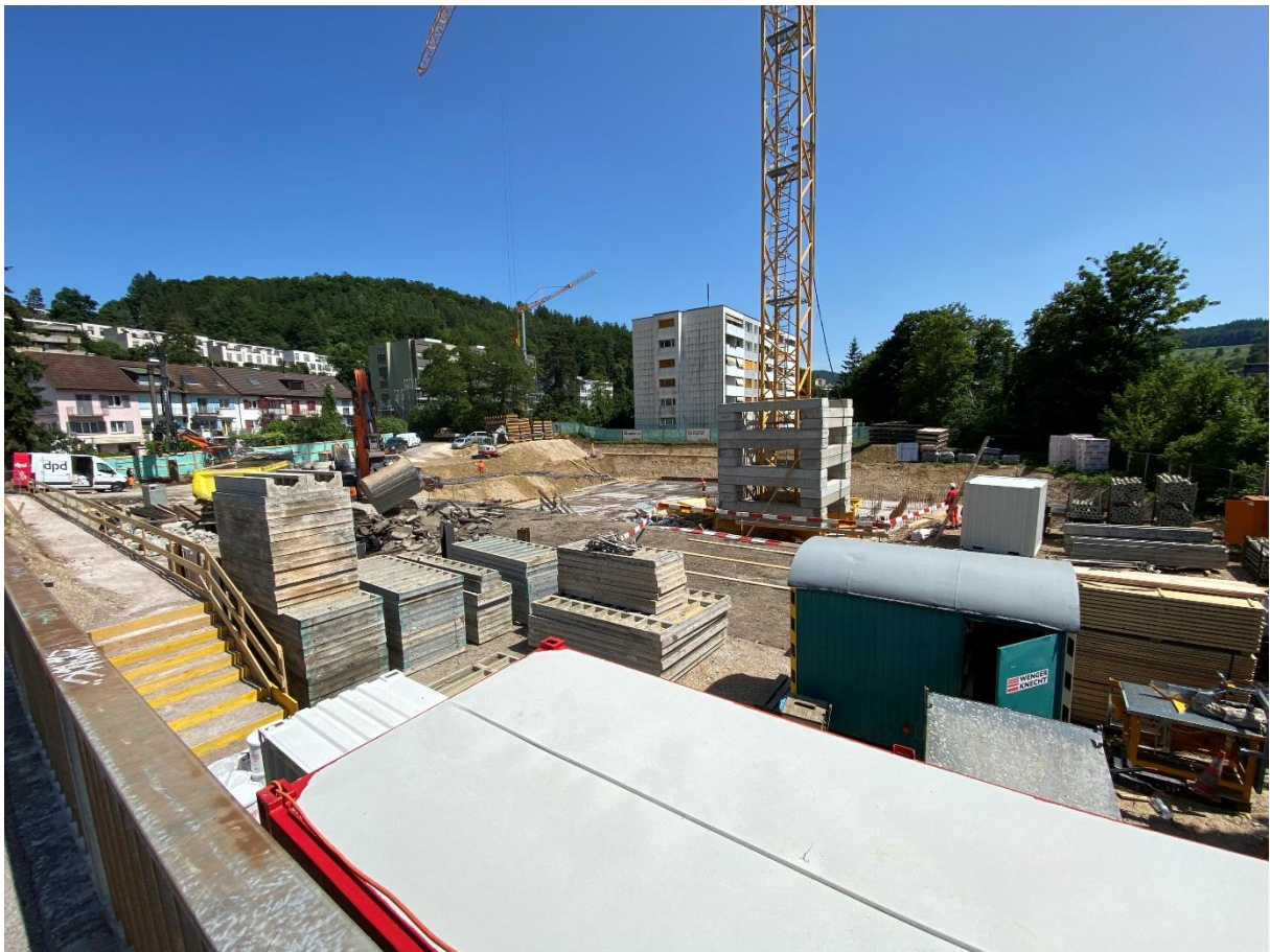
17.06. 2025: Aushub beendet, Fundament wird betoniert
