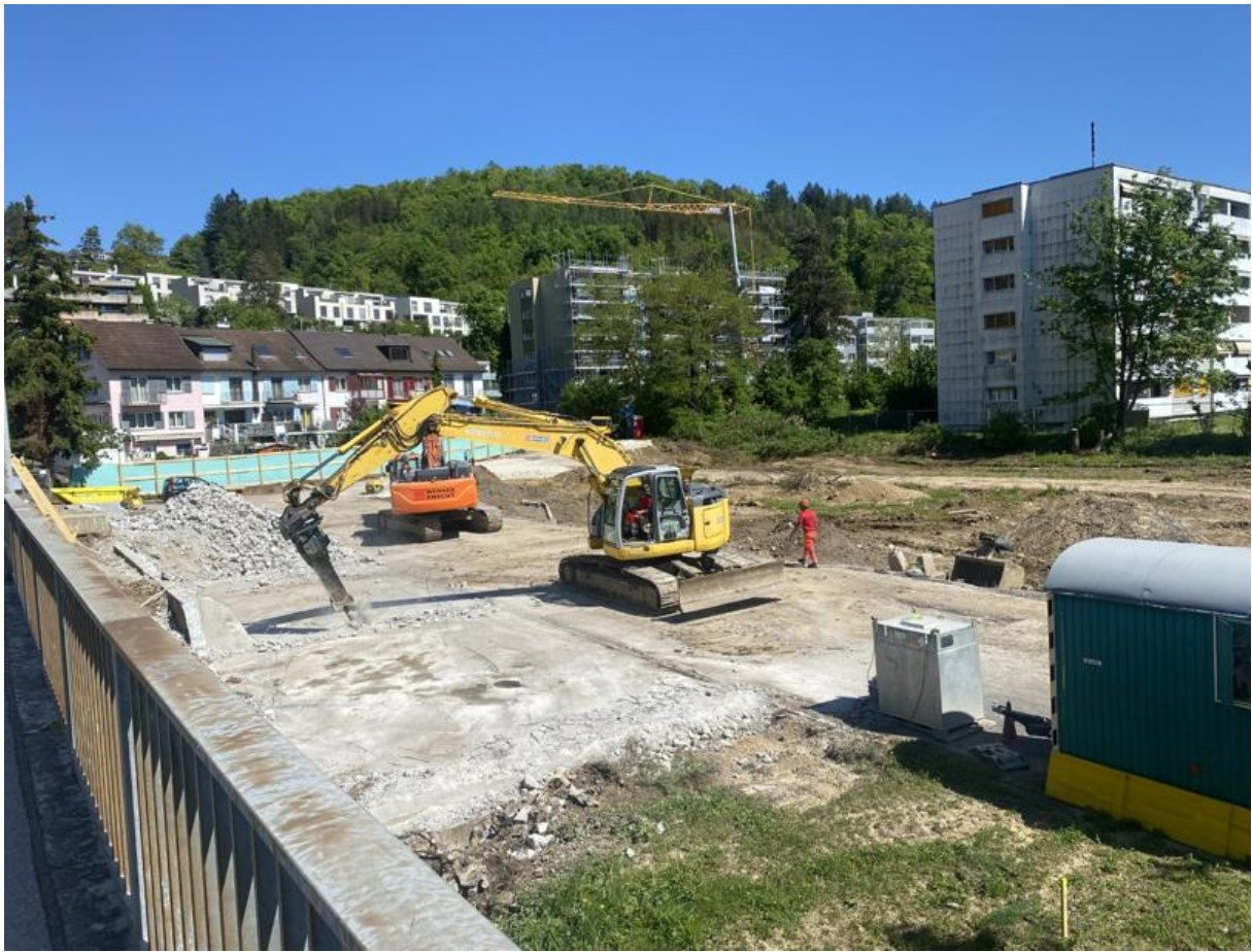
1. Mai 2025: Der Barackenunterbau ist entfernt
