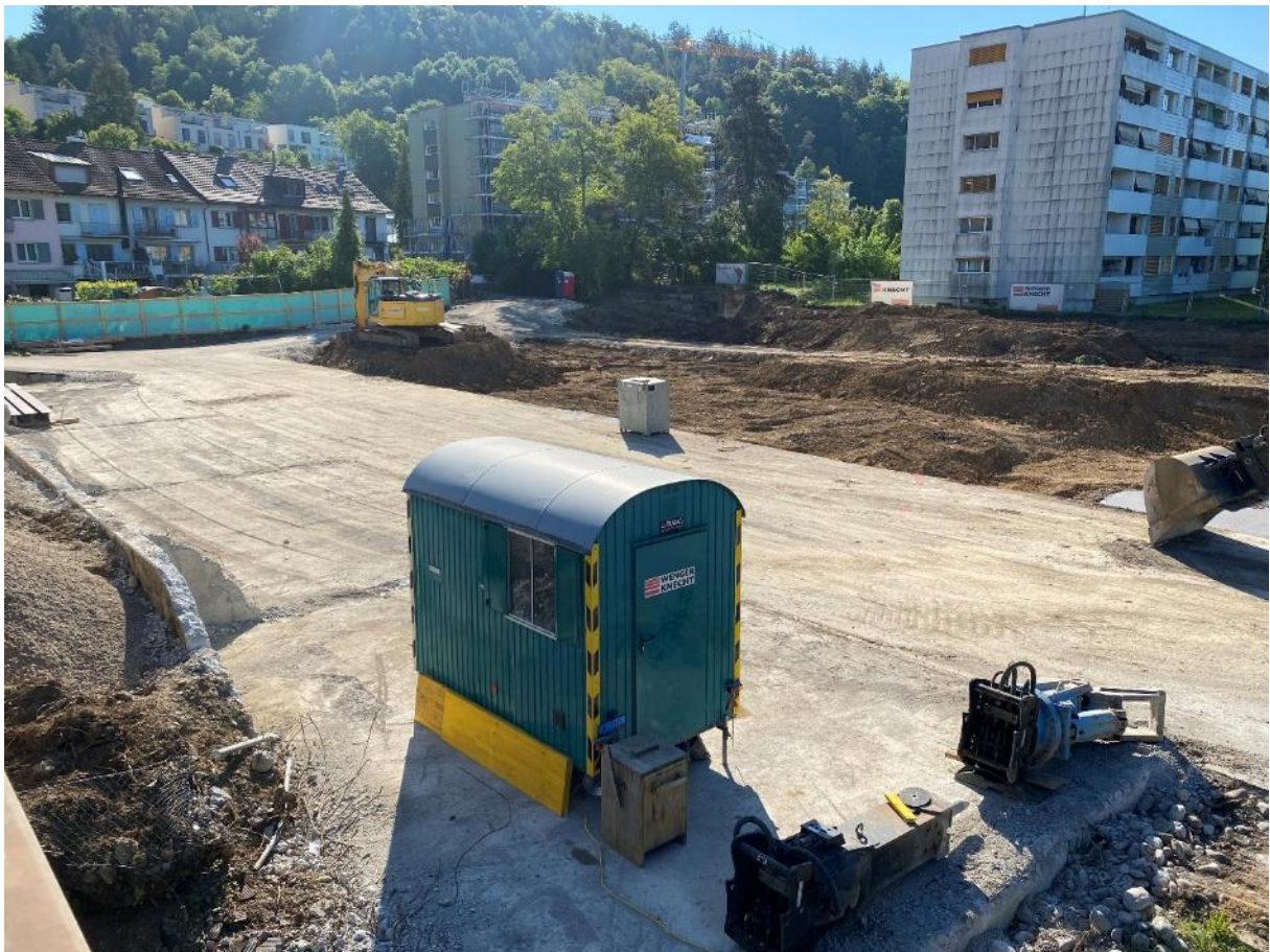
11. Mai 2025: Der Aushub beginnt
