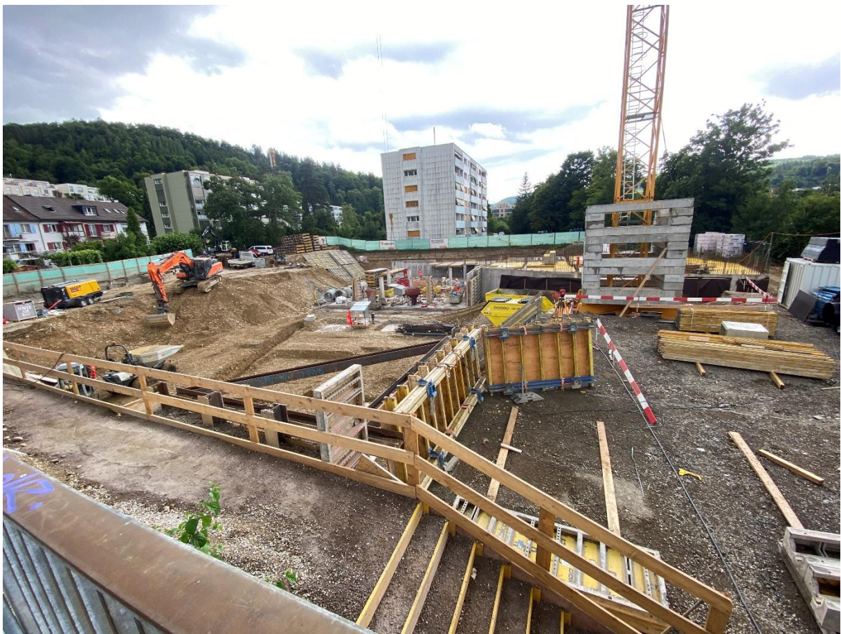
07.07.2025: Aushub 2. Block beendet, Block 1 Untergeschoss rechts fertig
