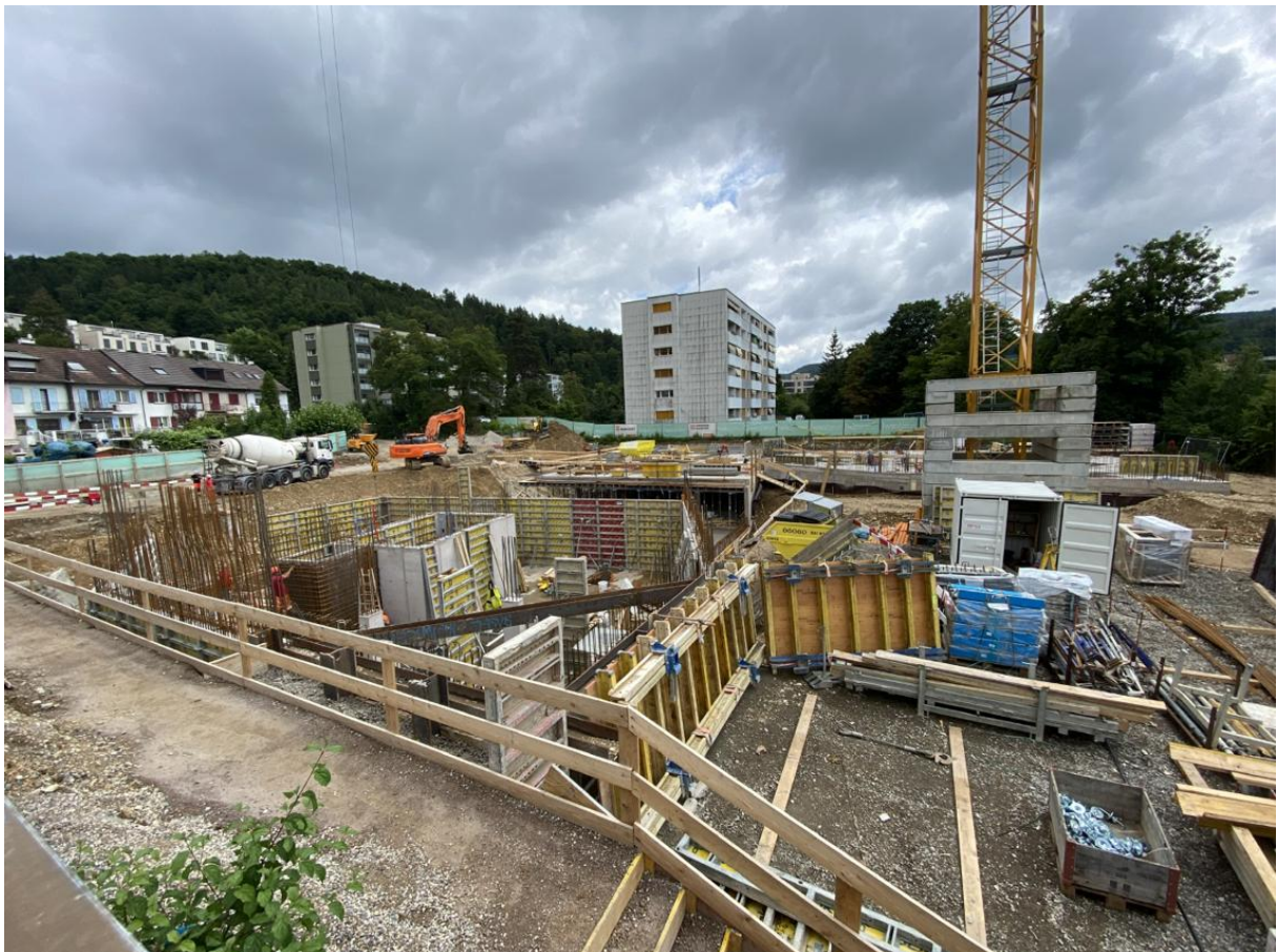
25.07.2025: Haus 3: Keller wird geschalt
