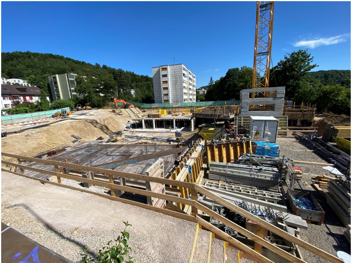
12.07.2025: Vor dem Betonieren des Fundaments vorne, hinten Untergeschoss fertig
