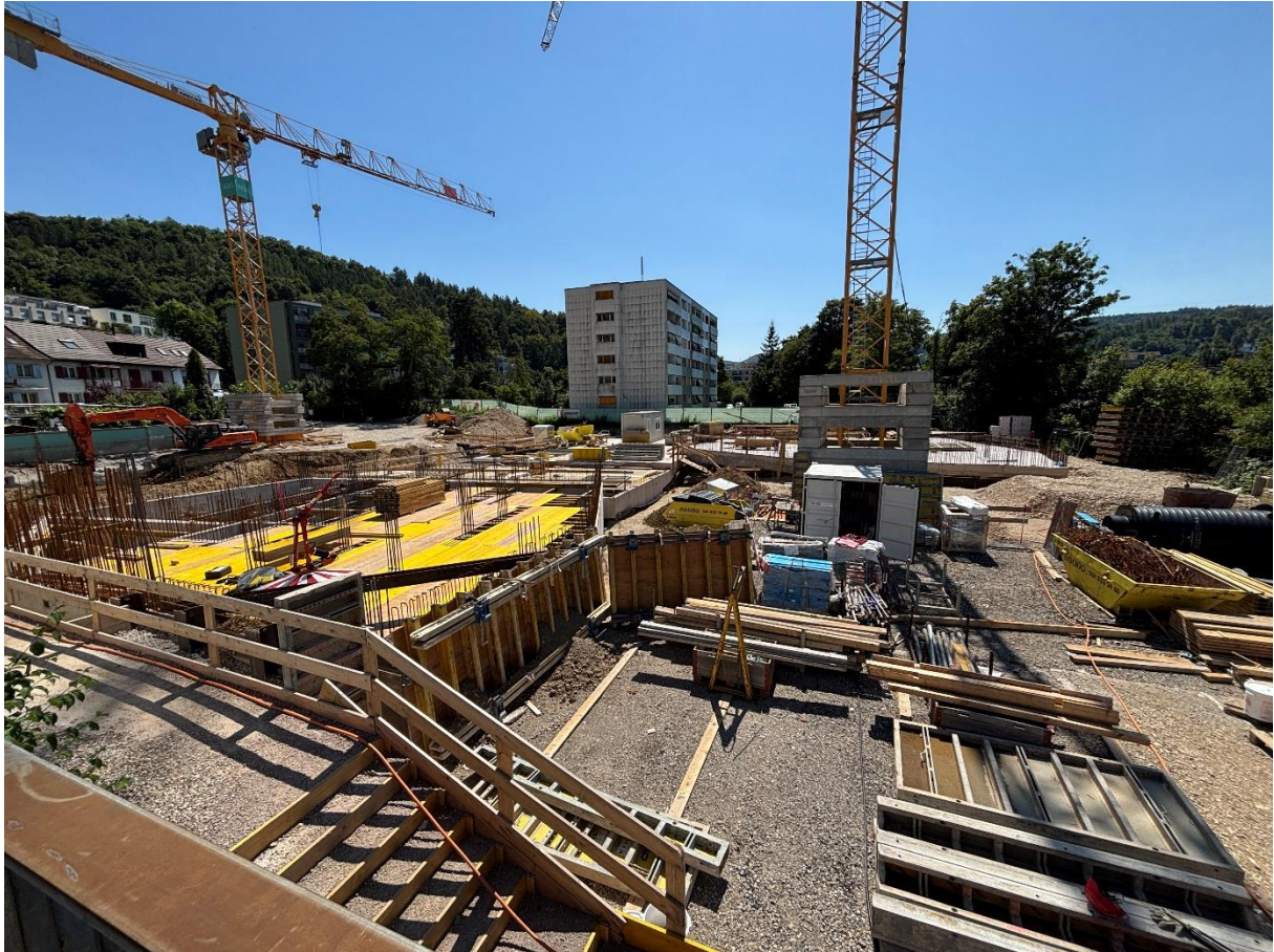
6.08.2025: Kellerdecke wird gedeckt, 2. Kran ist angekommen
