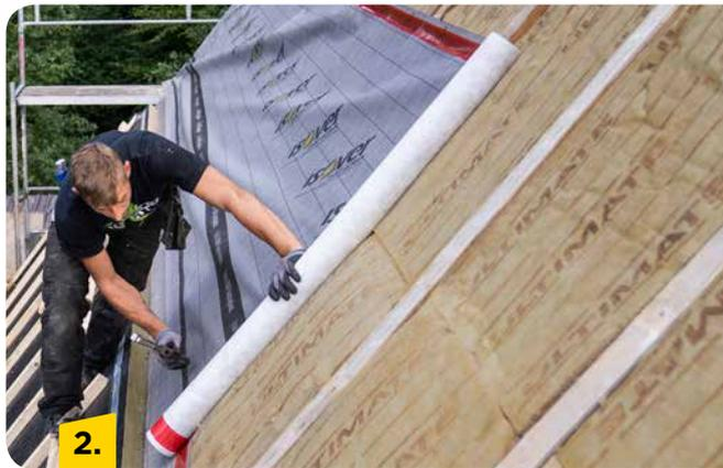
Vario® KM Supraplex-SKS bahnenweise von unten beginnend über die mit ULTIMATE ZKF-031 gefüllten Gefache verlegen. Nachfolgende Bahnen mit 10 cm Überlappung aufbringen.
