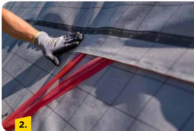
Folienüberlappung mithilfe der Selbstklebestreifen der Vario® KM Supraplex-SKS verkleben.
