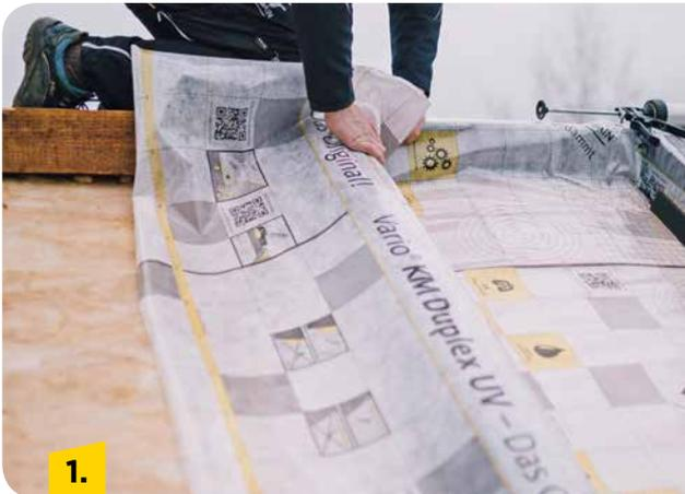
Integra UMP-032 als Nagelschutzplatte in die Gefache einlegen. Vario® KM Duplex UV schlaufenförmig um die Sparren verlegen. Die Klimamembran mit Vario® ZSL Sanierungsleisten sauber am Sparrengrund fixieren. Dies verhindert Hohlräume, die mit warmer Raumluft hinterströmt werden könnten. Alternativ zur Vario® KM Duplex UV kann auch die Vario® Xtra Safe verlegt werden.
