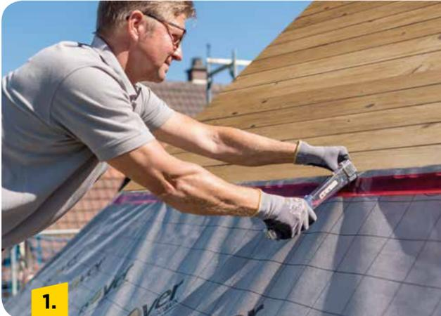
Vario® KM Supraplex-SKS bahnenweise von unten beginnend auf die Schalung verlegen. Nachfolgende Bahnen mit 10 cm Überlappung aufbringen.
