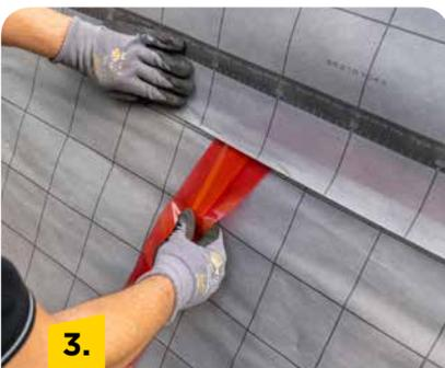
Folienüberlappung mithilfe der Selbstklebestreifen der Vario® KM Supraplex-SKS verkleben.
