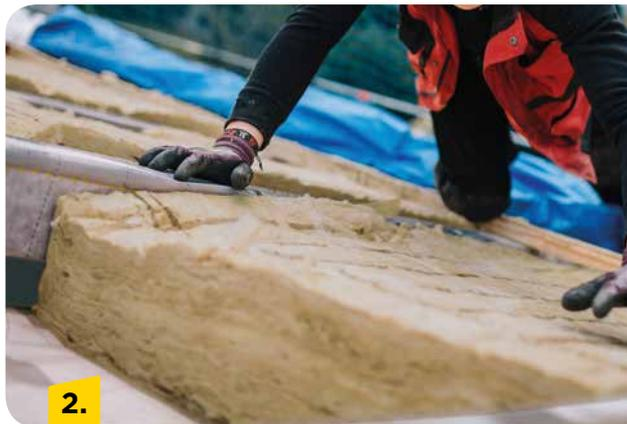
Den ULTIMATE ZKF-031 Zwischensparren-Klemmfalz zwischen die Sparren klemmen. Die Dämmung sollte das Gefach bis zur Oberkante der Sparren vollständig füllen.
