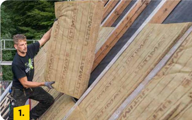
ULTIMATE ZKF-031 zwischen die Sparren klemmen. Dabei das Gefach vollständig bis zur Oberkante der Sparren mit den Dämmstoffmatten ausfüllen.
