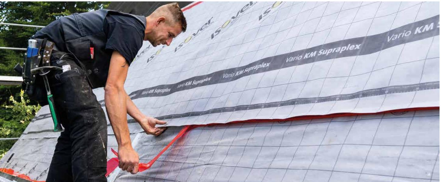
Was früher nur in seltenen Fällen geraten wurde, wird mit der Vario® KM Supraplex-SKS zum Standardfall. Dank der robusten Klimamembran können alle ISOVER Steildachsysteme auch mit der eben verlegten Vario® KM Supraplex-SKS unterhalb der Aufsparendämmung feuchtesicher ausgeführt werden. Je nach Konstruktionsaufbau und Anforderung bietet ISOVER eine Vielzahl an Möglichkeiten, bei denen Feuchteschutz und Wärmeschutz sicher Hand in Hand gehen.
