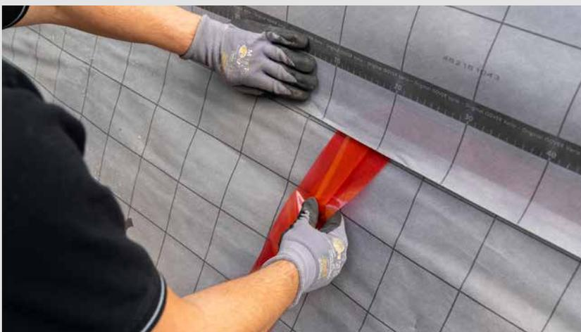
Die integrierten Klebestreifen vereinfachen die Verlegung der Vario® KM Supraplex-SKS deutlich.
