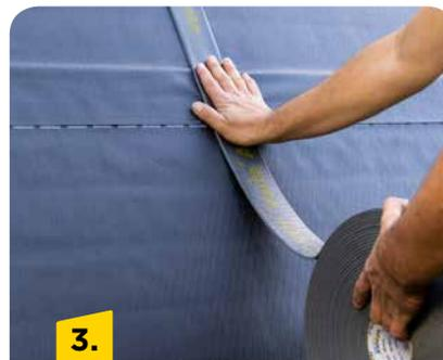
Das Nageldichtband Vario® AntiSpike im Sparrenverlauf auf die Unterdeckbahn kleben.
