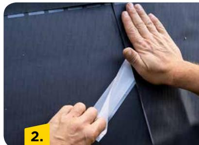
Die Überlappung der Unterdeckbahn anheben und das Abdeckband beider Klebestreifen lösen. Die Abdeckstreifen synchron abziehen und mit der Hand glatt anstreichen.
