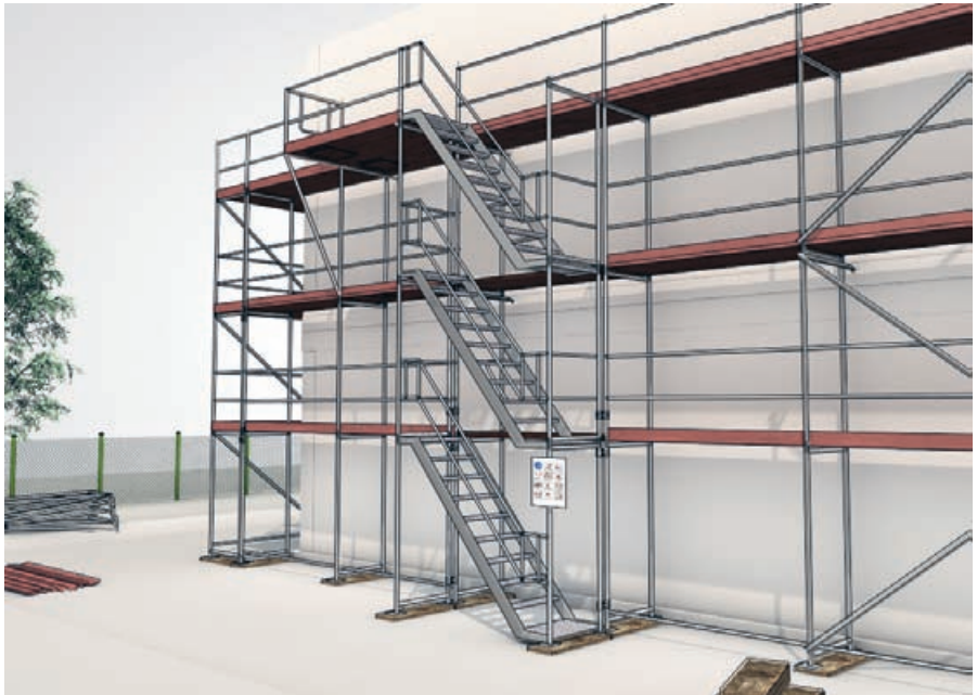
Bild 8: Gerüst mit Gerüsttreppe als Zugang
