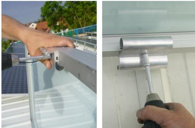
Abbildung 10: Montage „Modulbefestiger-Set“ hinten (links) und vorne (rechts)
