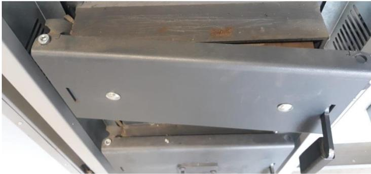
Wird die Tür vollständig geschlossen wird die Flamme erstickt. Bleibt die Tür vollständig geöffnet können Rauchgase in den Heizraum austreten!
