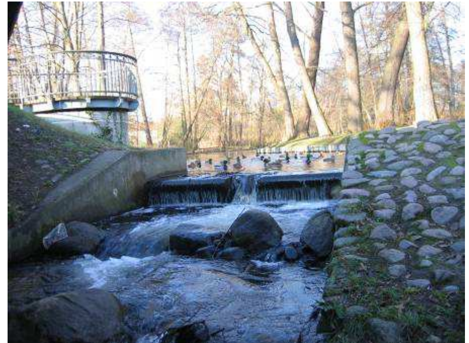
Fischtreppe (Zustand bis Anfang 2011)
