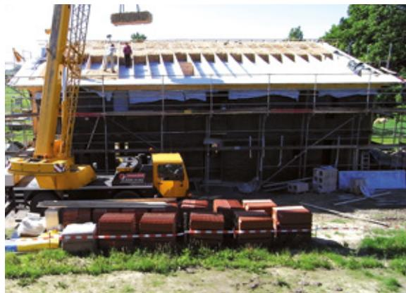
2. Einbau der Ballen zwischen die Sparren, die unterseitig eine Schalung und eine Luftdichtung erhalten haben.
