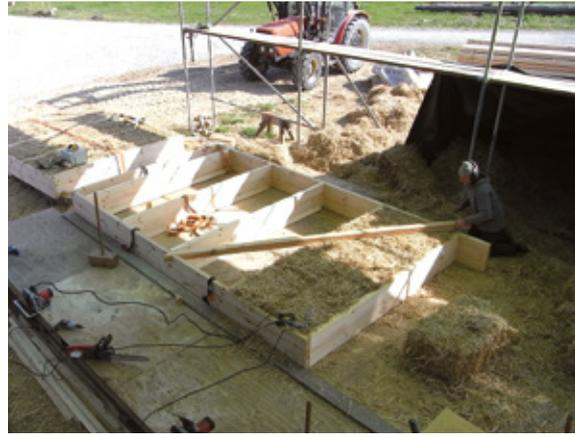
6. Vorbereitung des Einbaus einer diagonalen Strebe, die jedes Wandelement entweder nur zur konstruktiven Sicherung oder zur späteren Gebäudeaussteifung erhält.
