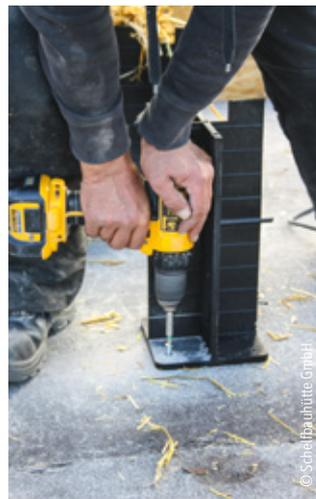
Der von der Schelfbauhütte entwickelte Kunststoffhalter
