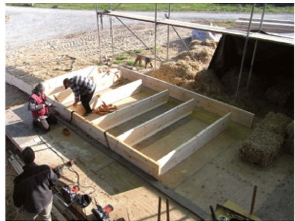
2. An den vertikalen Elementen, den Ständern, sind bereits seitlich Klemmleisten angebracht. Die Verbindung der Ständer mit Rähm und Schwelle erfolgt hier mittels Holzbauschrauben, die diagonal zur Faserrichtung der Ständer eingebracht werden.
