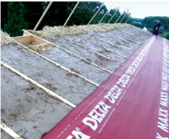
5. Dachstrohballe mit Lehmputzlage und Unterspannbahn.
