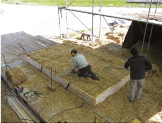
11. Nachrasieren der Oberfläche mit Heckenschere oder Elektrokettensäge.
