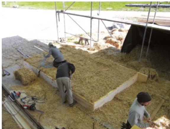
10. Nachstopfen von verbliebenen Lücken, Entfernen von Ballenschnüren (nur beim gezeigten, aufrecht stehenden Einbau der Ballen möglich).
