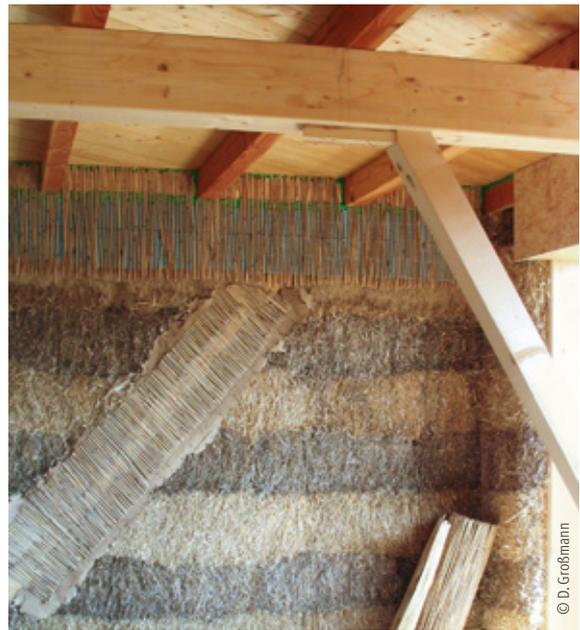
Strohwand mit Schilfrohr als Putzträger und blau durchscheinender Luftdichtungsbahn im Deckenanschlussbereich
