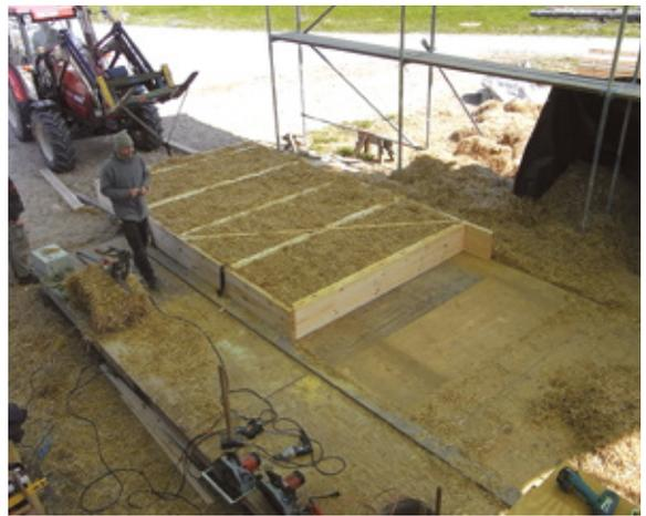
14. Fertiges Wandteil. Herstellungsdauer ca. 4 Stunden.
