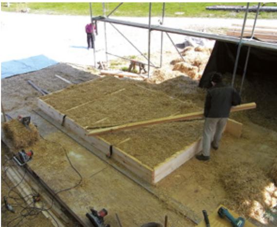
13. Einbau der oberen Klemmleisten.
