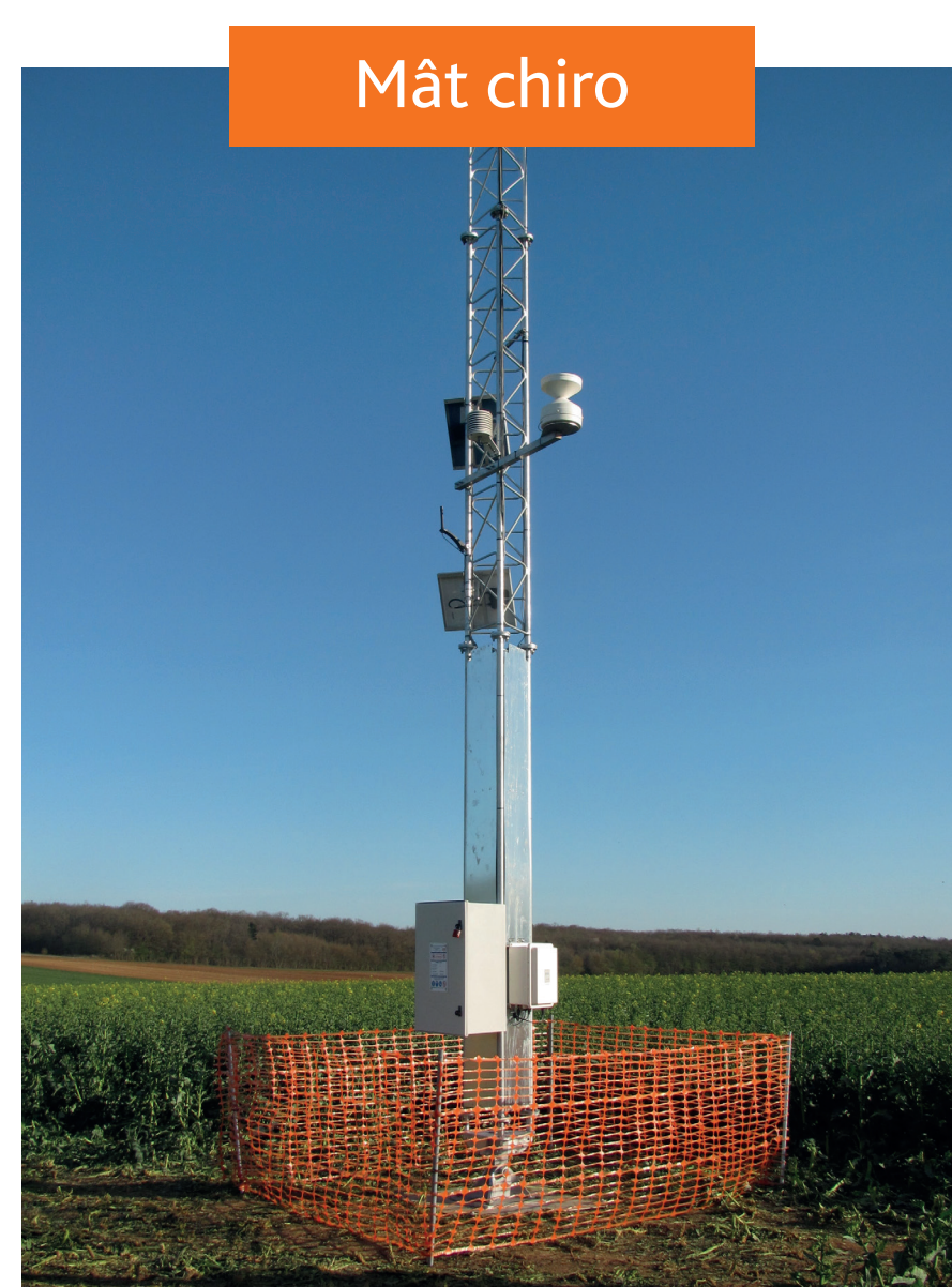
Installation d'un mât de 43m permettant les écoutes chauves souris
