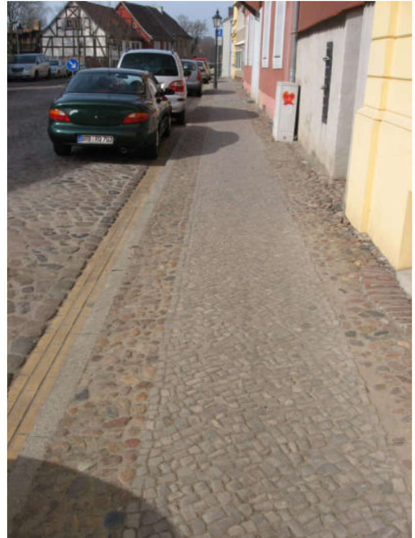
Domkietz, Fertigstellung 2001 Polygonalpflaster, Klinkerpflasterterrinne, Leseplaster und Bernburger Mosaik als historisch gewachsenes Fußgänger-Leitsystem
