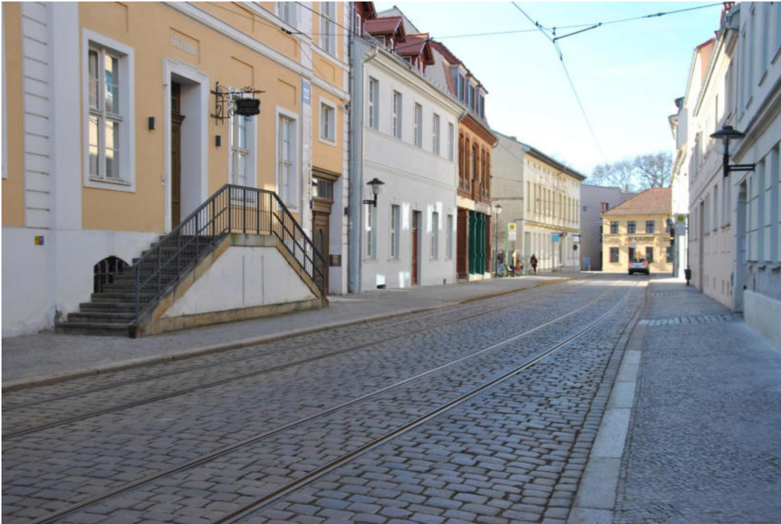
Ritterstraße mit Reihenpflaster, Fertigstellung 1997 Gehwege aus Granitmosaikpflaster und Bordstein im Haltestellenbereich erhöht
