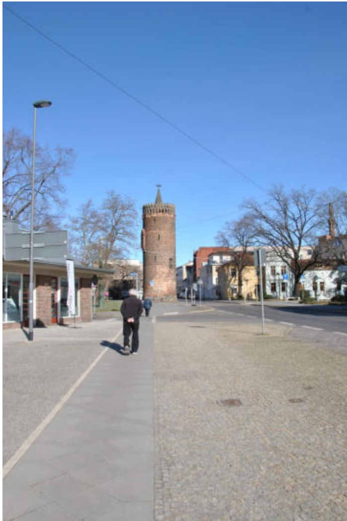
Barrierearme Straßenbeläge Fußgänger auf plattenbefestigtem Weg
