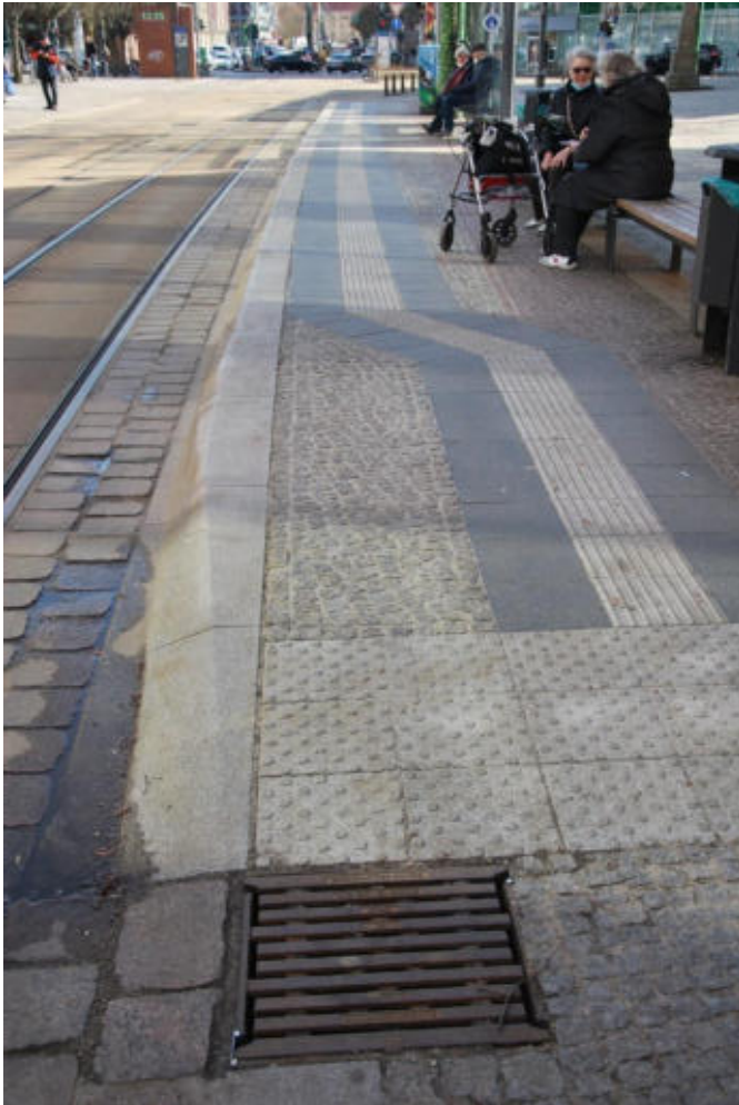
Bodenindikatoren aus hellem Granit, anthrazitfarbene Platten als Begleitstreifen
