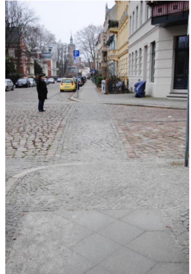
Abgestimmte barrierefreie Querung mit Belagswechsel und Bordsteinabsenkung
