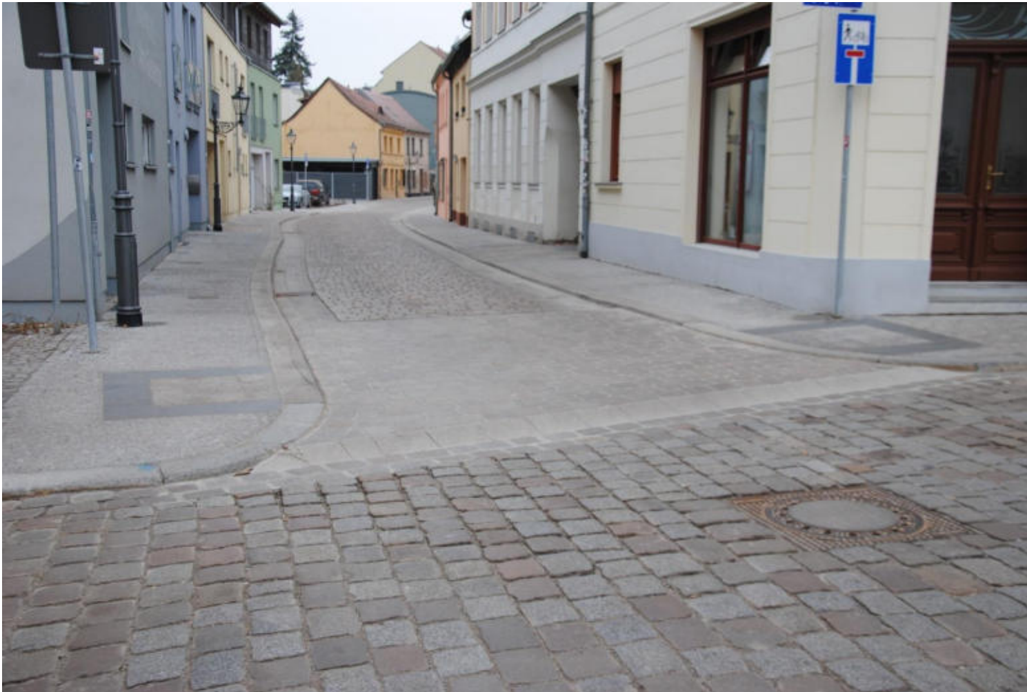
Wollenweberstraße, Fertigstellung 2020 Fahrbahn mit gebrauchtem geschnittenem Pflaster in ungebundener Bauweise, Querung in gebundener Bauweise
