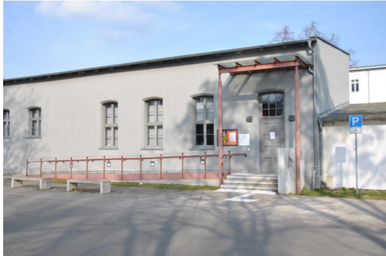
Gedenkstätte für die Opfer der Euthanasie-Morde, Zustand 2021 Eingangssituation mit nachträglich ergänzten Bodenindikatoren vom Behinderten- parkplatz zur Eingangstür, kontrastreiche Informationstafel, Hinweise in Braille- Schrift
