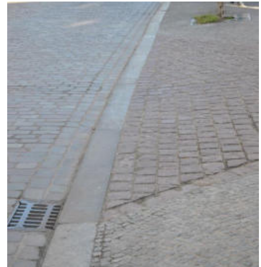
Mühlentorstraße, Fertigstellung 2010 Fahrbahn mit gebrauchtem geschnittenem Pflaster in gebundener Bauweise, Gehweg in Mosaikpflaster mit Grundstückszufahrten in Ausführung wie Fahrbahn (Abb. rechts oben)
