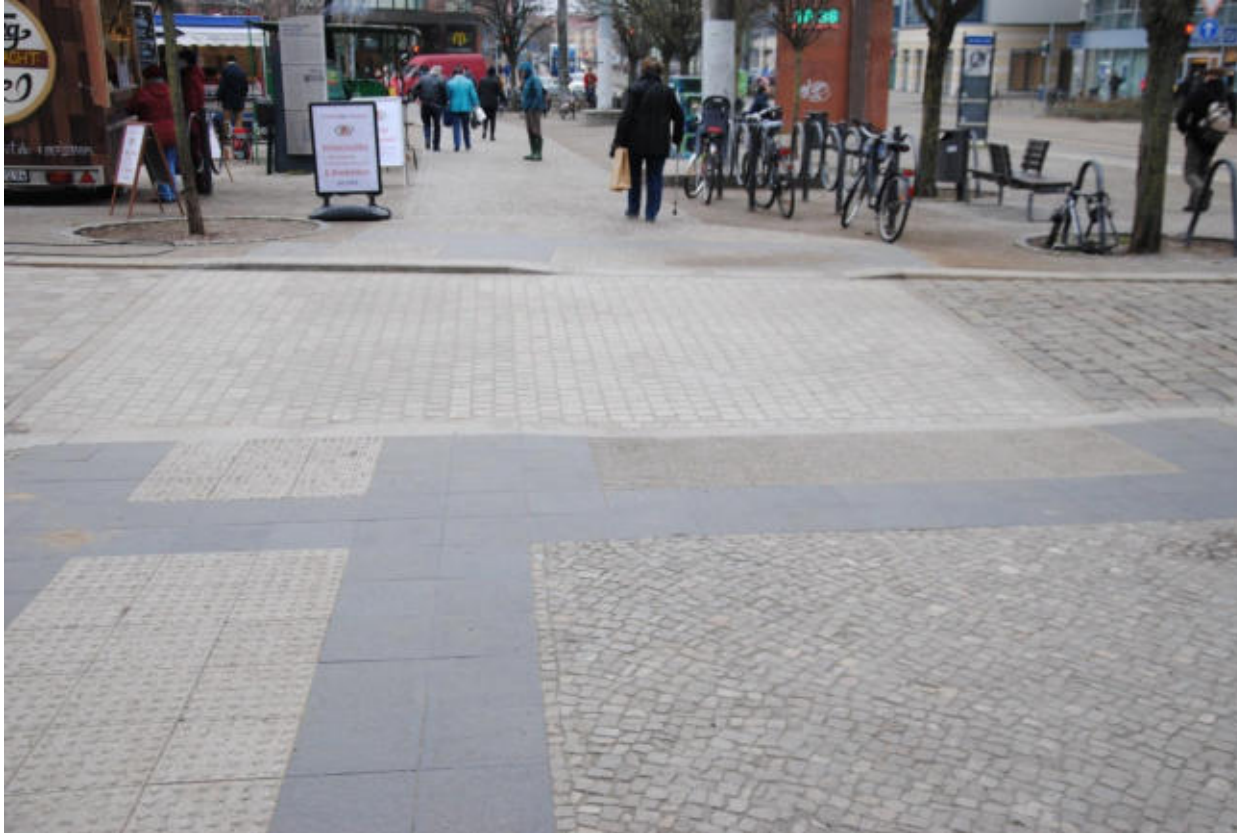
Hauptwegebeziehung Molkenmarkt DIN-gerechte Querungshilfe mit Natursteinmaterialien, Fertigstellung 2020 Prüfung des Leuchtdichtekontrastes gemäß DIN 18040-3 im Labor erfolgt
