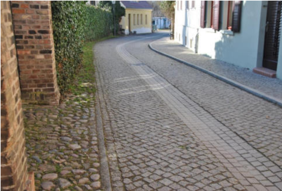
Burgweg, Fertigstellung 2013 verkehrsberuhigter Bereich mit Leseplaster, ungeschnittenem Kleinpflaster und Bernburger Mosaik
