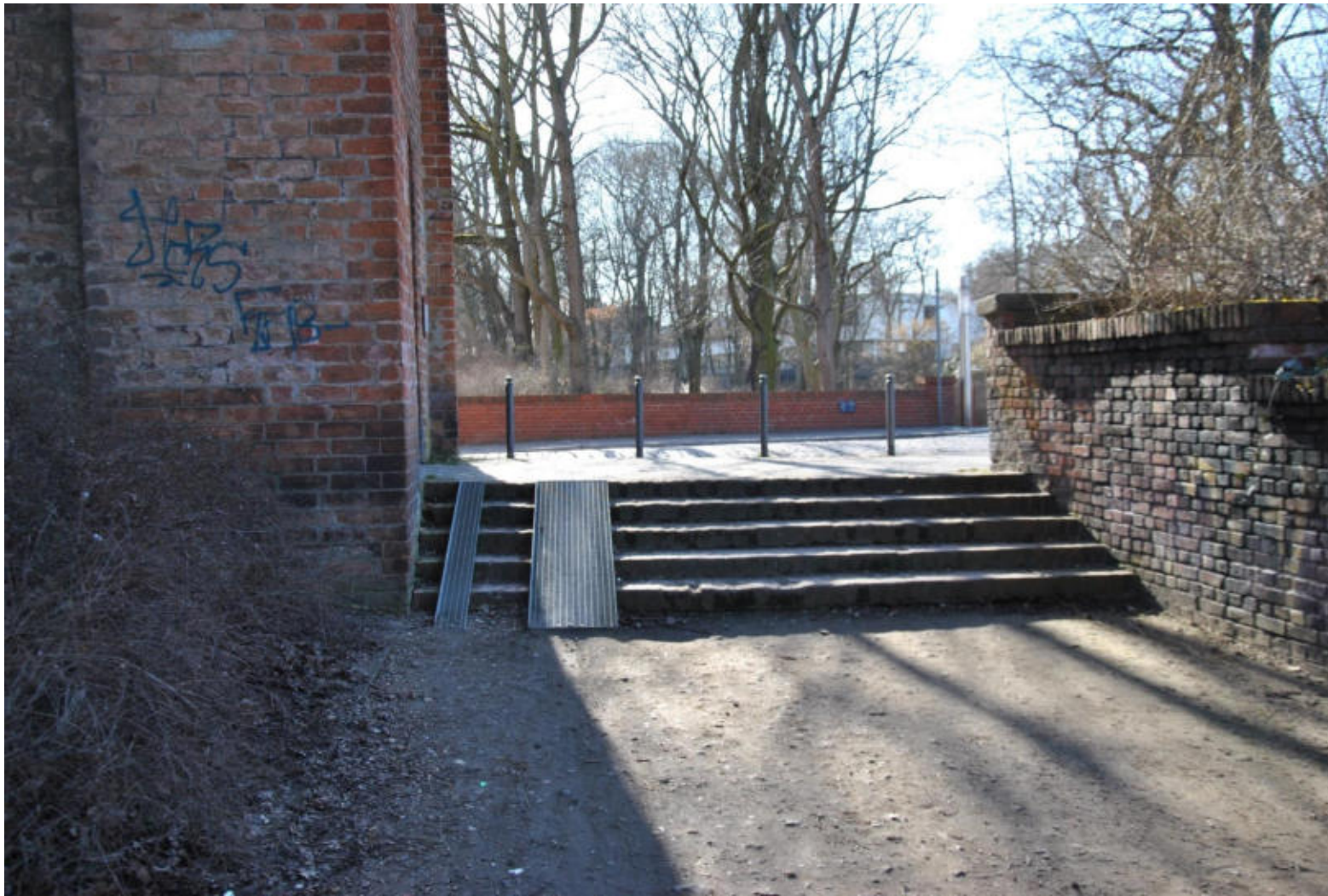
Provisorische Rampenlösung am Walther-Rathenau-Platz, Aufnahme 2021
