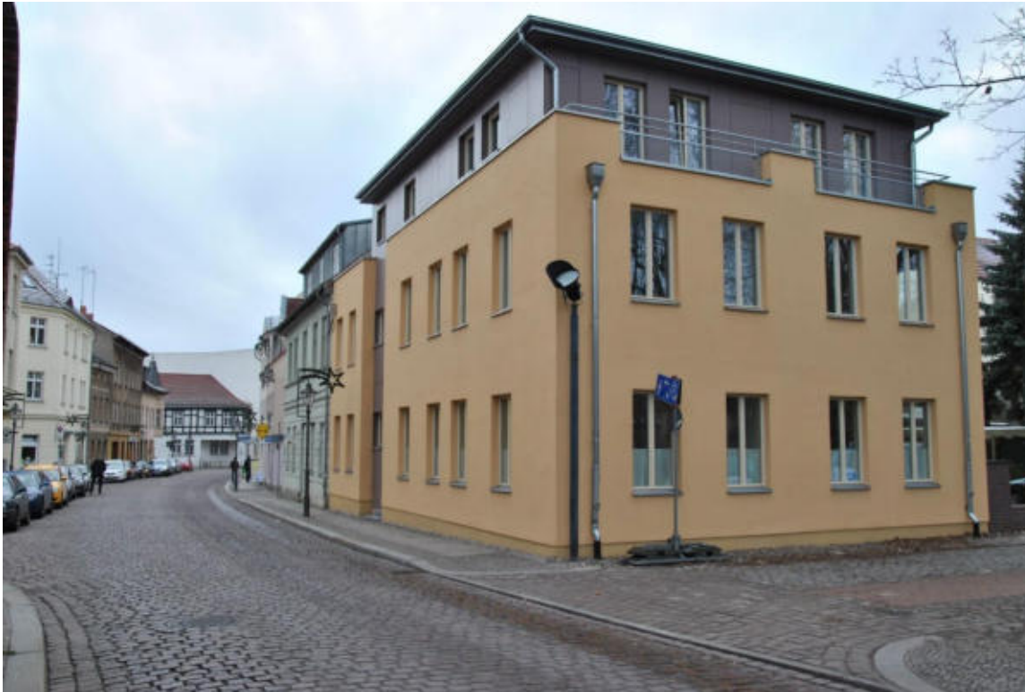
Rathenower Straße, Fertigstellung 2003 Fahrbahn mit neuem gestocktem Pflaster in vollgebundener Bauweise, Gehwege mit Berliner Platten
