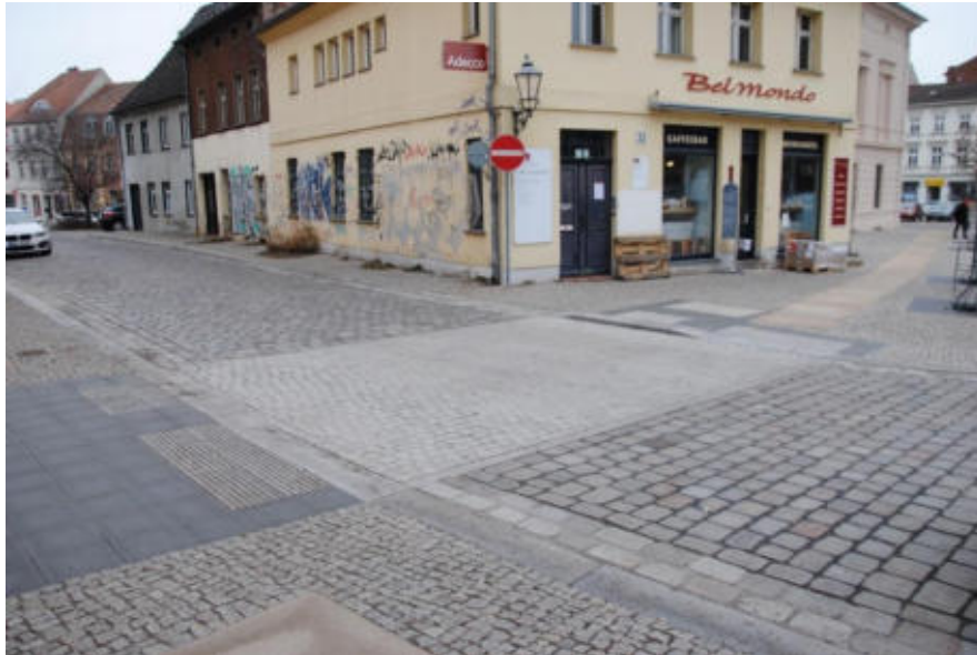
Gering frequentierte Wegebeziehung Molkenmarkt DIN-gerechte Querungshilfe mit Natursteinmaterialien Fertigstellung 2020
