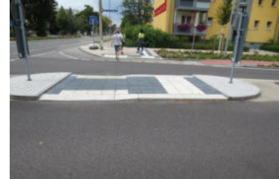
Freiherr-von-Thüngen-Straße DIN-gerechte Querungshilfe außerhalb des Sanierungs- gebietes, Fertigstellung 2015
