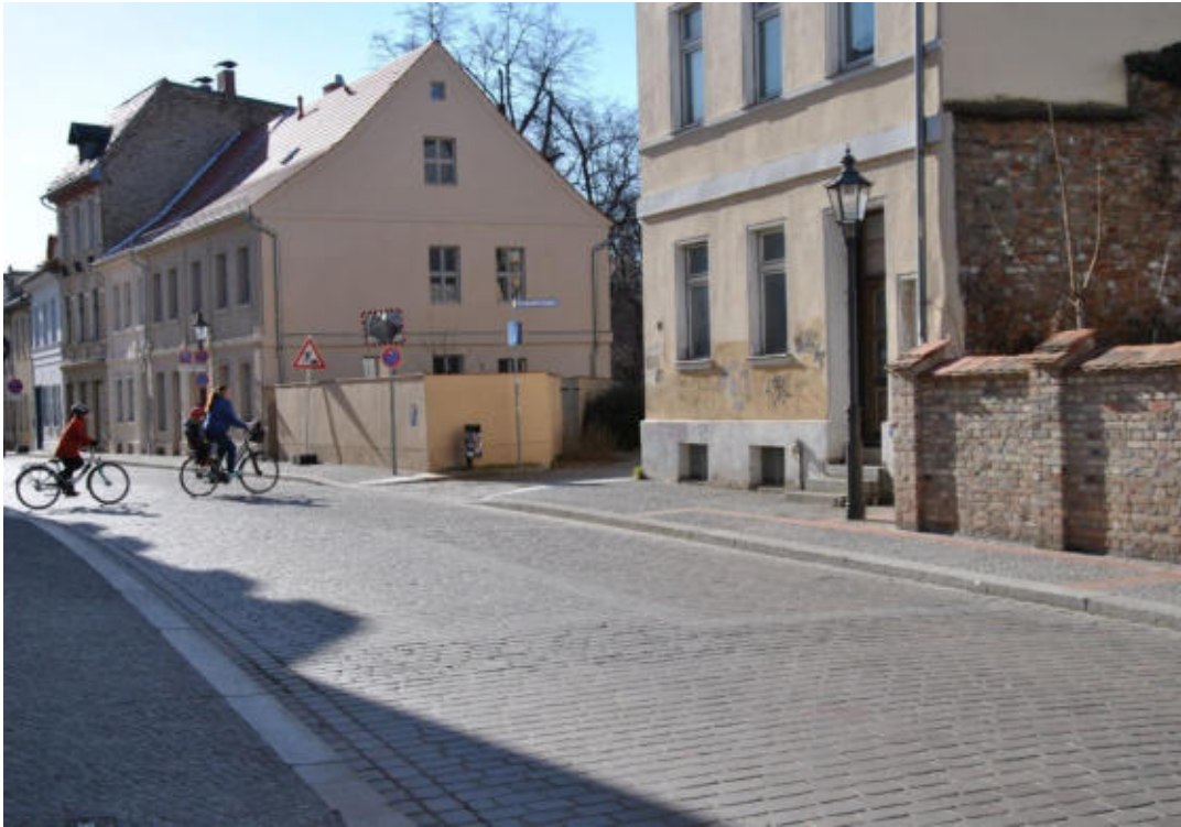
Mühlentorstraße, Fertigstellung 2010 Fahrbahn mit gebrauchtem geschnittenem Pflaster in gebundener Bauweise, Gehweg in Mosaikpflaster mit Grundstückszufahrten in Ausführung wie Fahrbahn (Abb. rechts oben)
