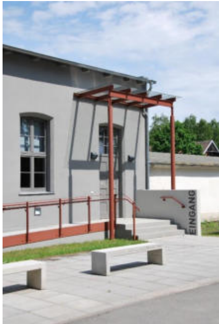
Eingangssituation mit Rampe und Treppenanlage Zustand 2013
