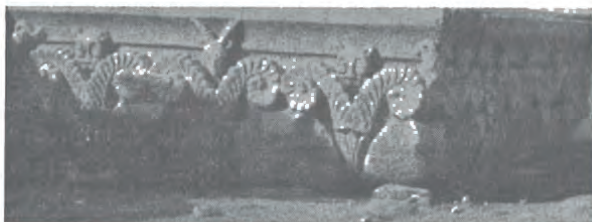
Detalle de la pila de Almiria, de 1926
