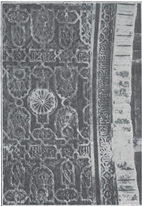
Detalle de la parte central del intradós.
