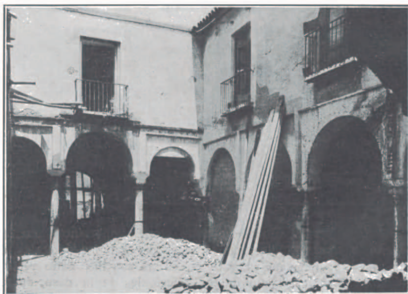
Frente del patio que mira al norte.
