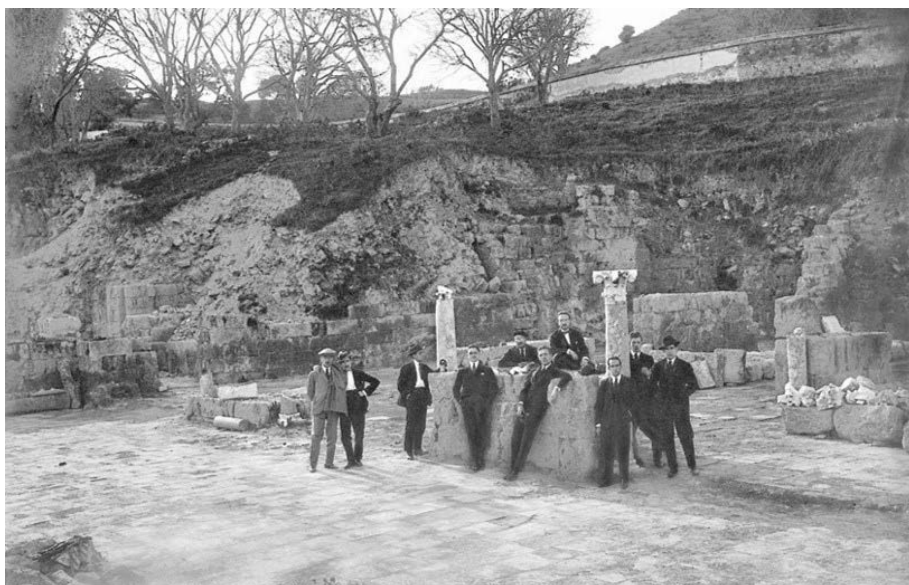
Fig. 1. Salón Basílical Superior tras su excavación en 1918
