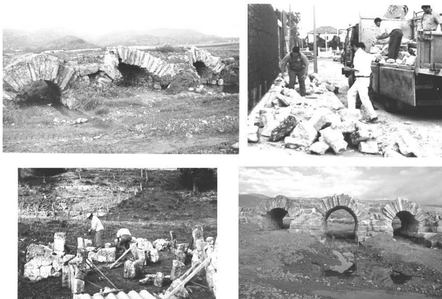
Fig. 21. Puente de los Nogales: expolio, recuperación de sus dovelas fragmentadas en un chalet, recomposición en Madinat al-Zahra y restauración
