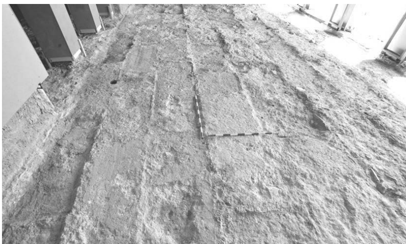
Fig. 22. Excavación de las camas de pavimento de mármol en el Salón de Abd al-Rahman III
