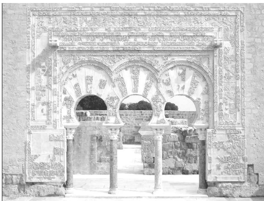
Fig. 20. Portada de la Casa de Yafar, situación previa y restauración del año 2000
