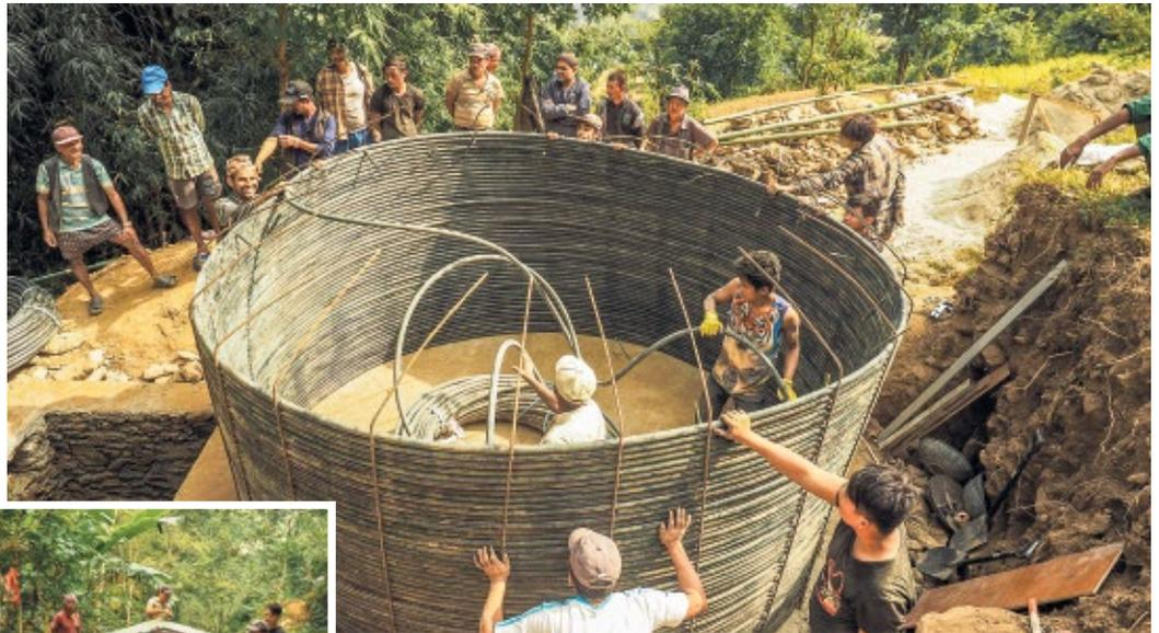
**Dank vereinter Kräfte** und ausgeklügelter, aber einfacher Technik nimmt das 15000-Liter-Wasserreservoir (Bild oben) Gestalt an. Es wird künftig sicherstellen, dass die Dorfbewohner an den acht Zapfstellen täglich frisches und sauberes Wasser holen können. Mitten im unzugänglichen Wald entsteht das Drei-Kammer-Absetzbecken (Bild links). Einheimische Arbeiter leisten das ihre zum Gelingen des Bauwerks.
