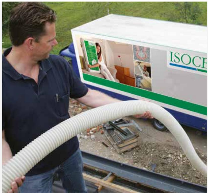
Der Einblas-Fachmann kommt mit seinem LKW auf die Baustelle und bringt gleich alles mit, was er braucht: Einblasmaschine und Zellulosefasern.
