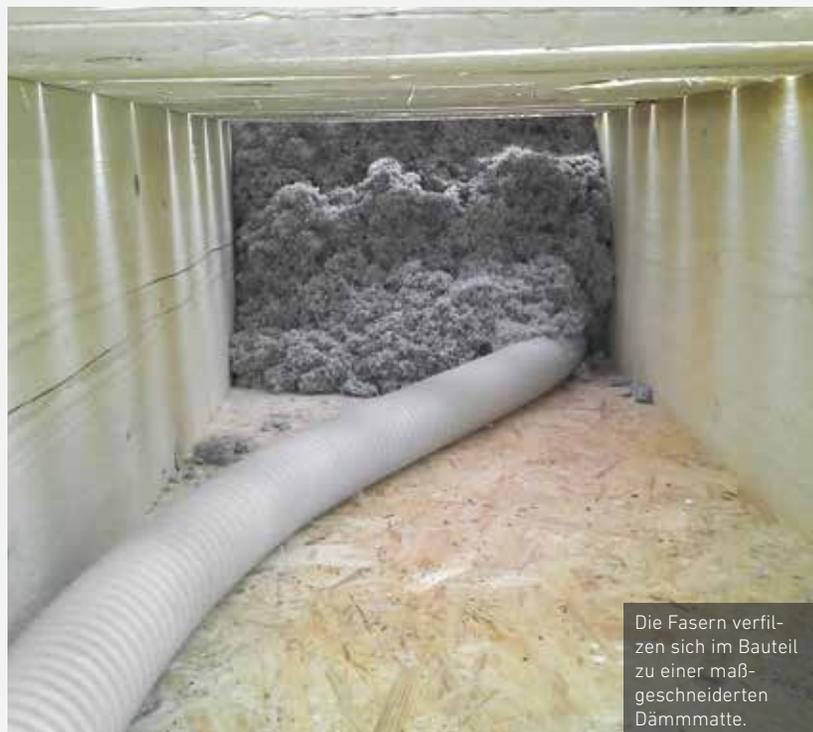
Die Fasern verfilzen sich im Bauteil zu einer maßgeschneiderten Dämmmatte.
