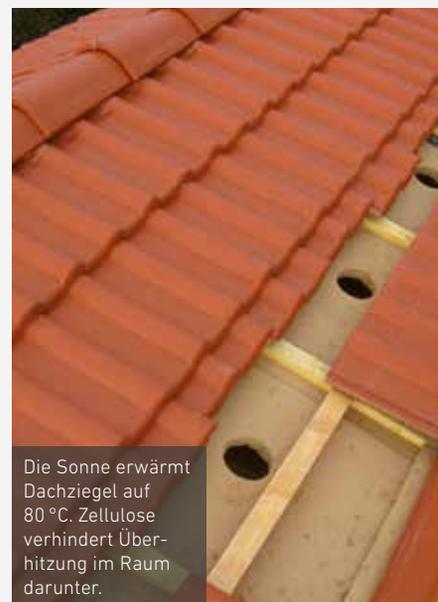
Die Sonne erwärmt Dachziegel auf 80 °C. Zellulose verhindert Überhitzung im Raum darunter.
