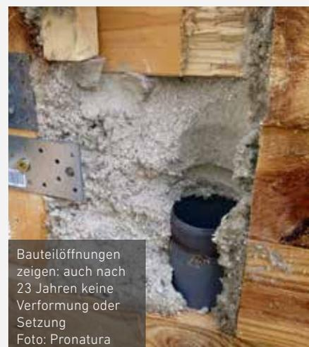
Bauteilöffnungen zeigen: auch nach 23 Jahren keine Verformung oder Setzung
