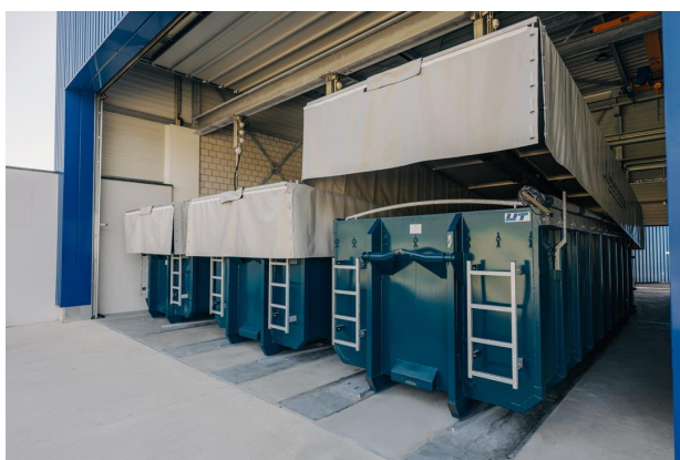
Schlammmentwässerungsgebäude mit Stellplätzen für drei Abrollmulden
