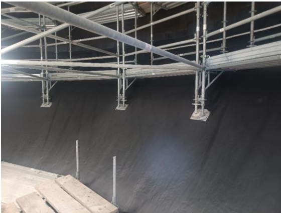
Neu beschichtete Betonoberfläche
