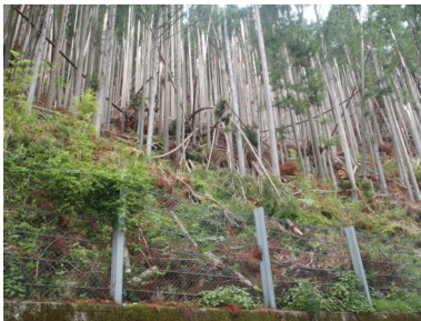
整備前(雪害被害直後)
