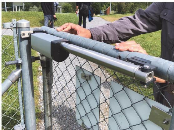
Abbildung 6: Stabile Schliessfeder
