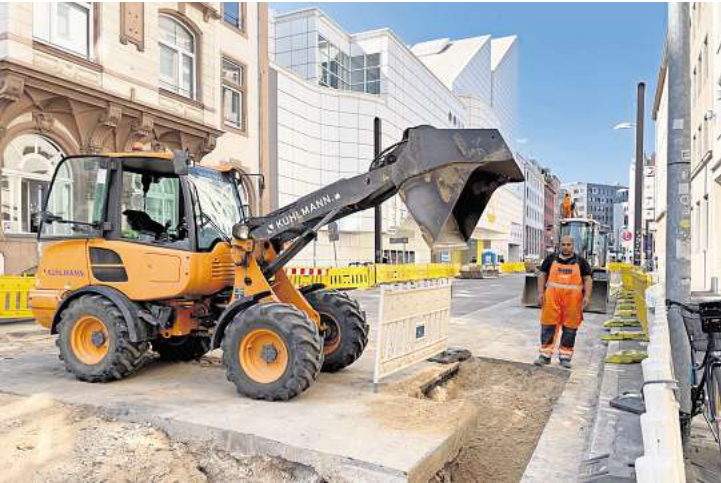
AUFTAKT: Die Bauarbeiten für die Erneuerung der Prinzenstraße haben bereits begonnen.
