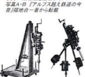
写真 インガソル製蒸気動力削岩機
