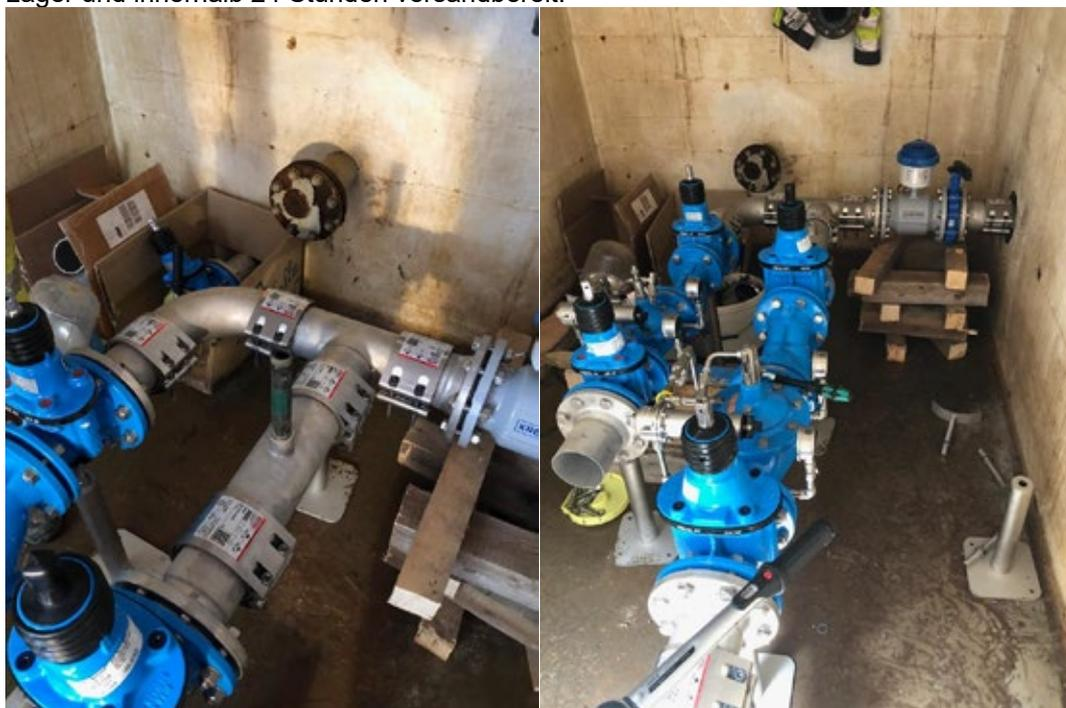
Verrohrung Pumpenschacht DN100 mit Edelstahl-Formteilen und Straub-Grip-Rohrkupplungen
