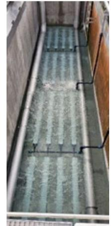
Bild Blasentest Tripple-A-Becken
