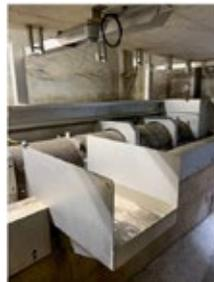
Ein anderer Einsatzort des VEGAPULS C 21/C 22 findet sich in der Erfassung der Wasserspiegellinie in den Ableitungsrinnen der drei Nachklärbecken. Durch Gegenüberstellung wird eine gleichmäßige Beschickung der Nachklärbecken mittels Regelklappen im Zulauf ermöglicht.
