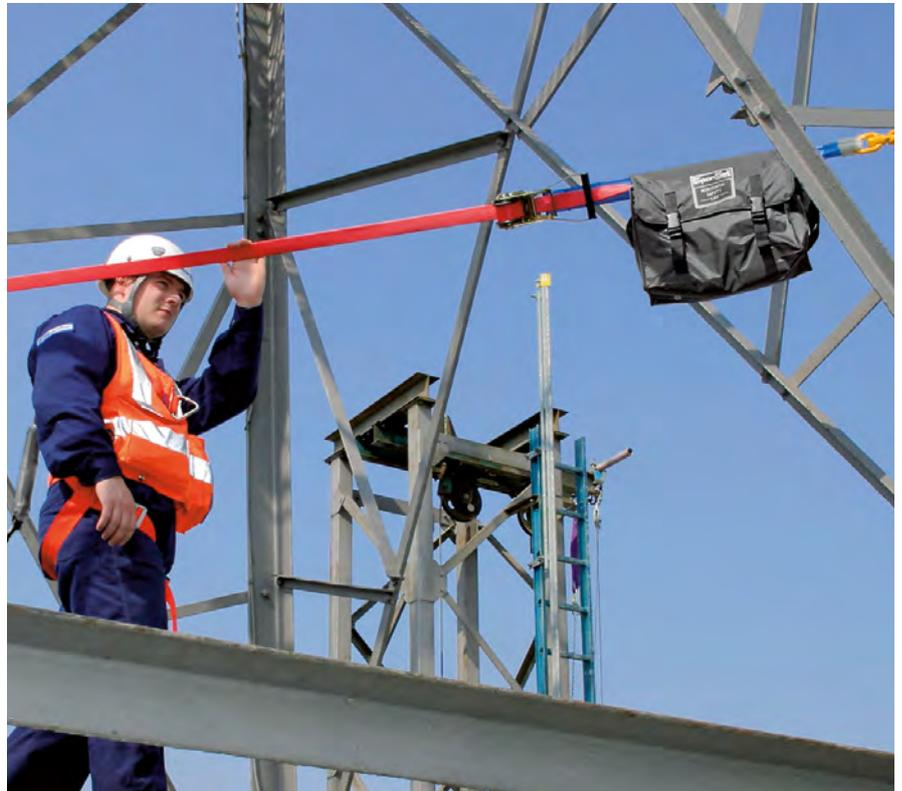
Wenn Sie bei der Arbeit in der Höhe häufig den Standort wechseln, müssen Sie Ihr Sicherungssystem immer wieder neu anbringen. Der HSL macht es Ihnen leicht: Sie spannen den Horizontalgurt zwischen zwei Haltepunkten, mit der Ergo-Zugrutsche legen Sie eine Vorspannung an. Das lose Gurtende verstauen Sie in der Transporttasche – eine Stolperfalle weniger. Sie gewinnen Bewegungsfreiheit über die gesamte Länge des Sicherungsgurtes.
