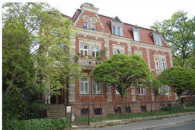
Abb. 30: Zechmeyers ehemaliges Haus Lange Zeile 33, Nürnberg (Quelle: eigenes Foto aus dem Jahr 2020)
