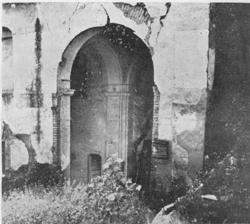
(Fig. 20.) Parte inferior de las mismas ruinas
